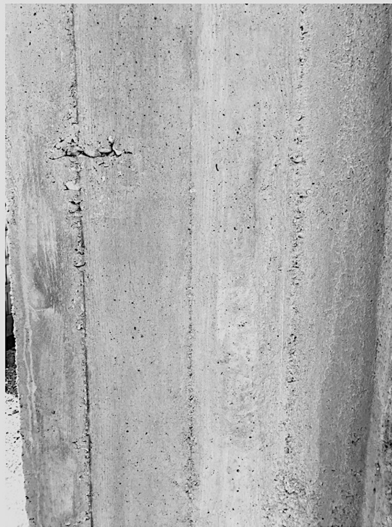
Béton projeté matricé
