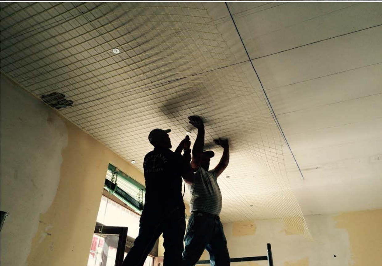
La rete in GFRP e una fase di posa.
