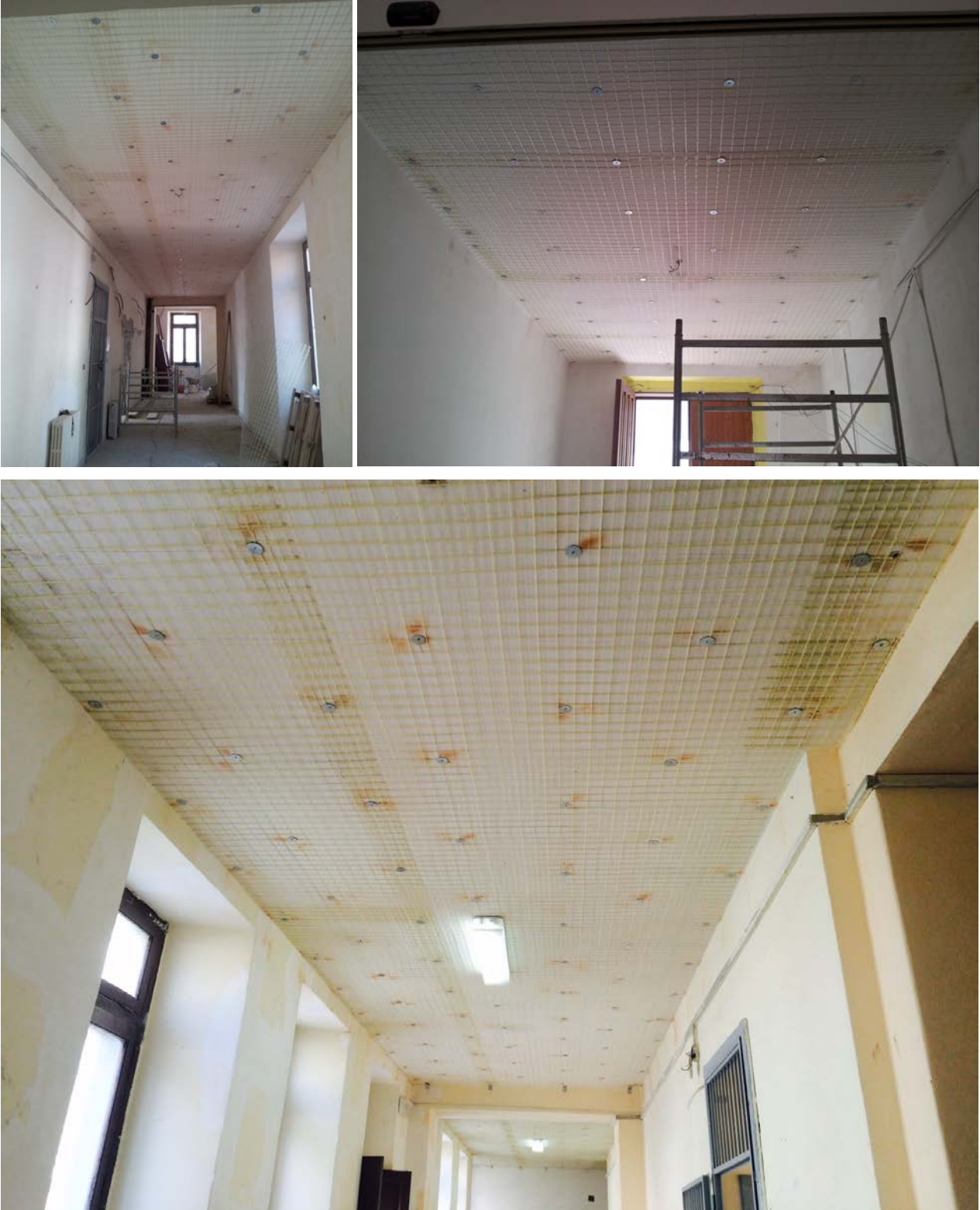
I solai messi in sicurezza con la posa del sistema LIFE+
