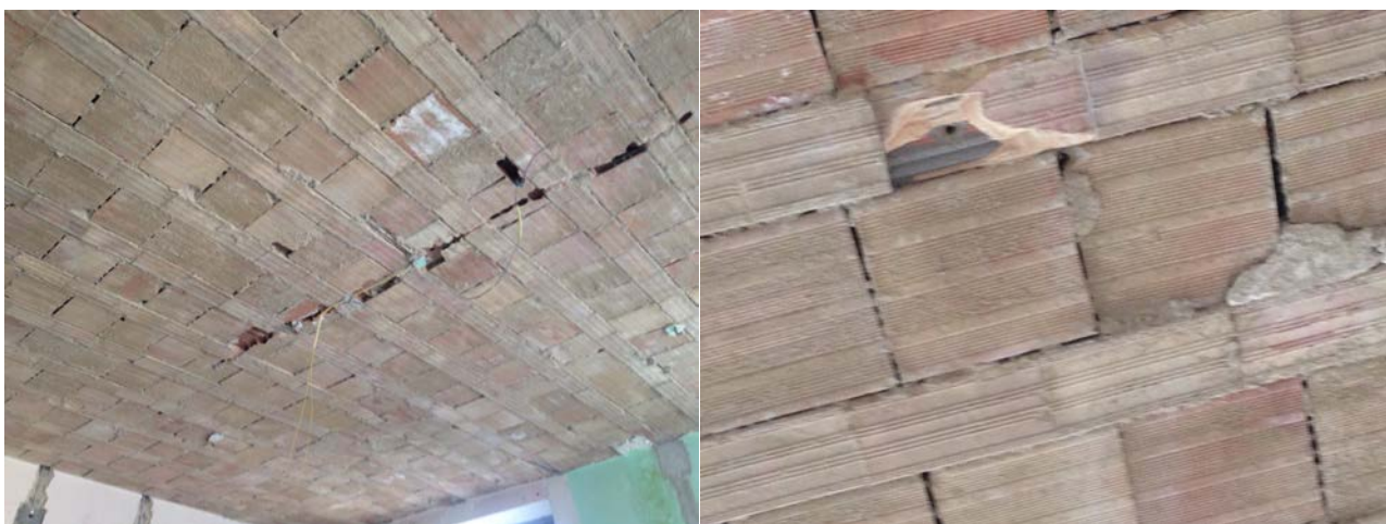
Il solaio in latero-cemento dopo la rimozione dell'intonaco.
