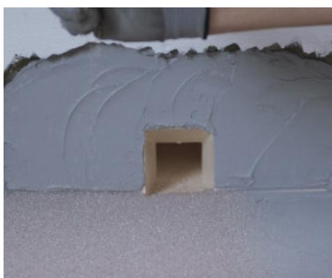
Impermeabilizzazione dello scarico con Drain Front
