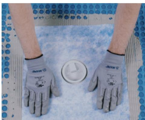
Impermeabilizzazione dello scarico con Drain Vertical/Drain Lateral
