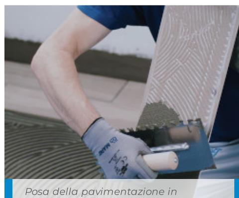
Posa della pavimentazione in ceramica o materiale lapideo con idoneo adesivo Mapei di classe non inferiore a C2
