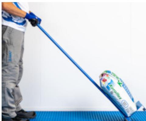
Pressatura di Mapeguard UM 35 con il rullo Mapeguard Roller
