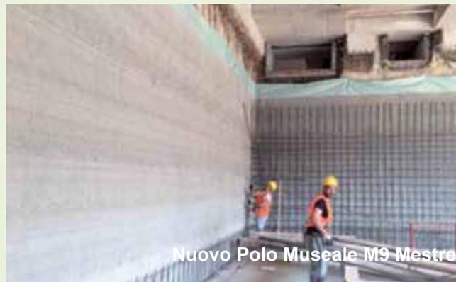
La membrana **DUAL SEAL** per le sue particolari caratteristiche tecnologiche e per l'affidabilità riscontrata in milioni di m<sup>2</sup> applicati nel mondo risulta particolarmente indicata nell'impermeabilizzazione di opere di ingegneria civile e idraulica quali fondazioni, parcheggi interrati, stazioni metro, gallerie artificiali e a cielo aperto stradali e ferroviarie, strutture sotto falda, vasche interrate, bacini idrici e di raccolta acque, giardini pensili ed arredo urbano.
