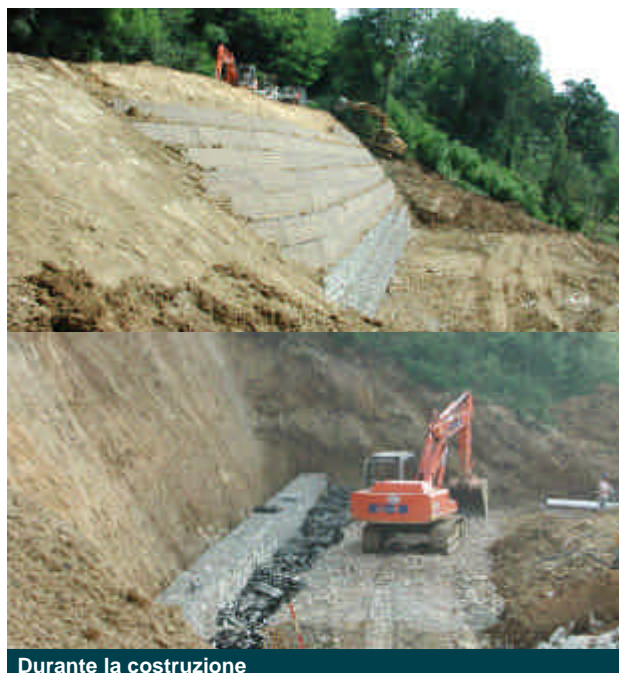
Durante la costruzione
