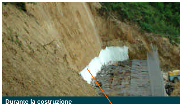
Durante la costruzione
