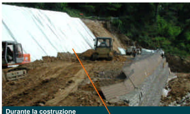
Durante la costruzione
