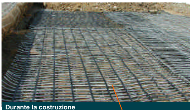
Durante la costruzione
