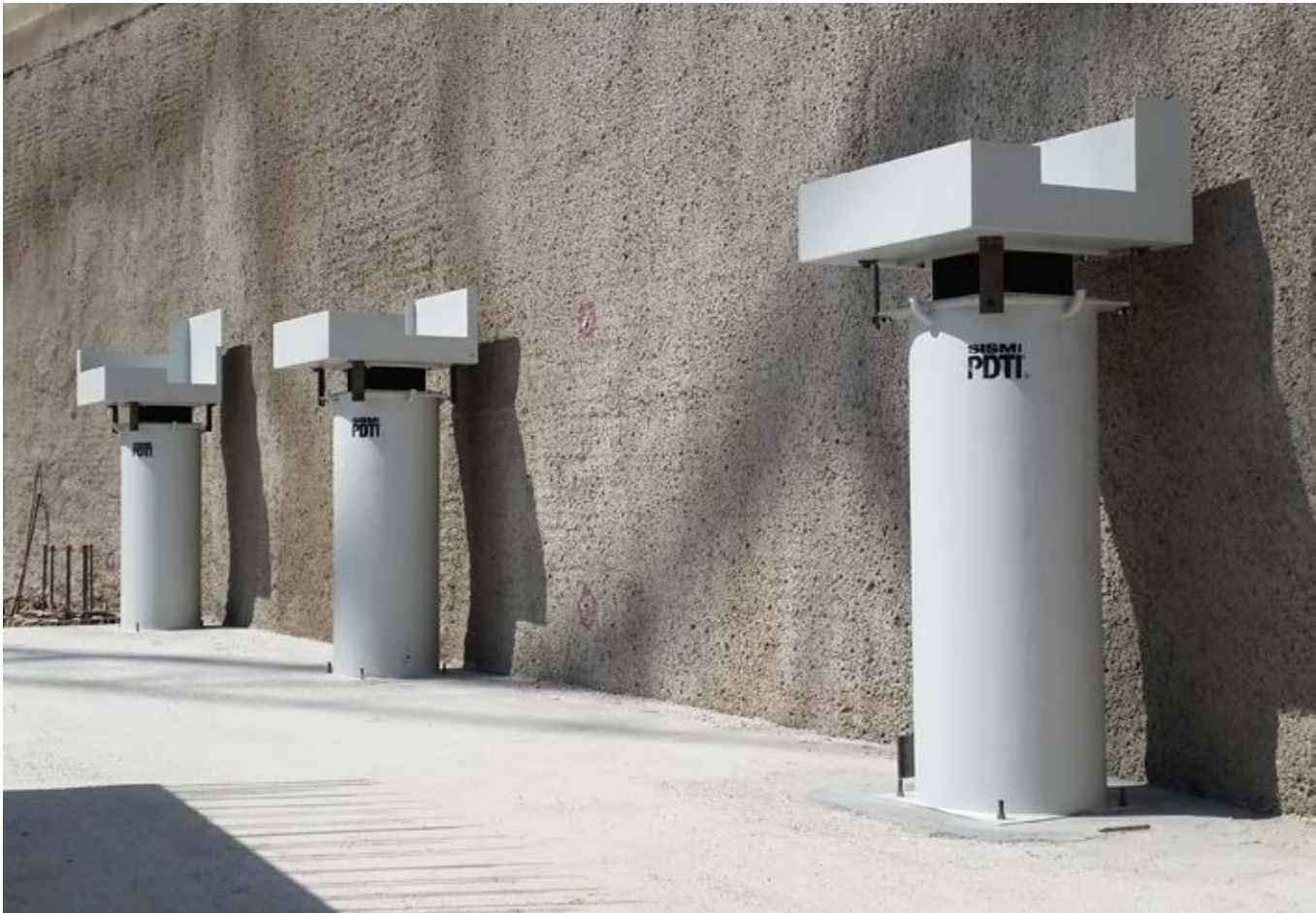
▽ Pilastri NPS® Slim Sismi impiegati per la sede Angelini Pharma di Roma.
