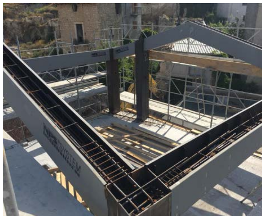
△ I pilastrì NPS® Slim permettono un'ottima flessibilità.
