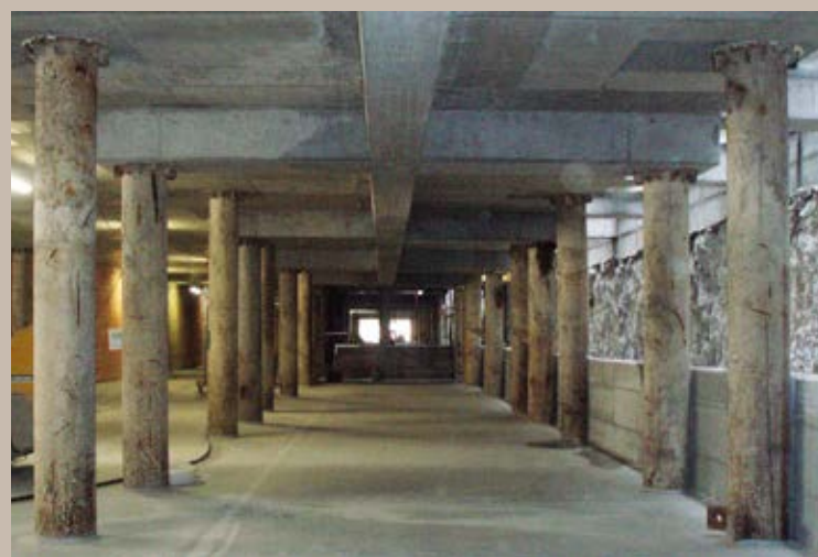
△ Pilastri NPS® e travi NPS® impiegati per la realizzazione del cantiere dal piano campagna a scendere.
