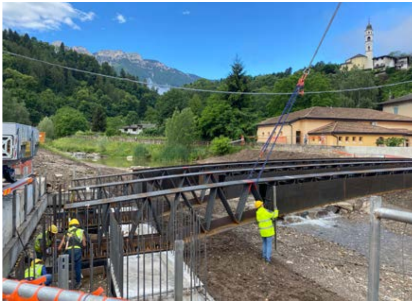
△ Realizzazione del ponte a campata unica, Calceranica (TN).
