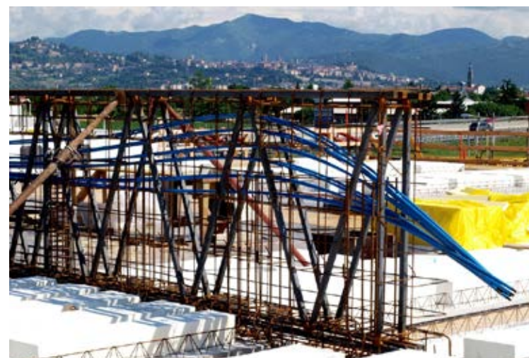
△ Esempio di impiego con solai a lastra tipo predalles.
