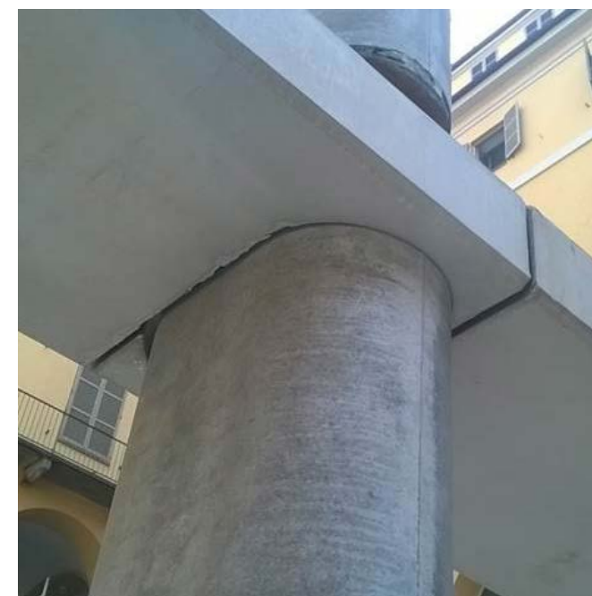
▽ La Trave NPS® Cls con collare sagomato contorna il pilastro ovale NPS® Style+.
