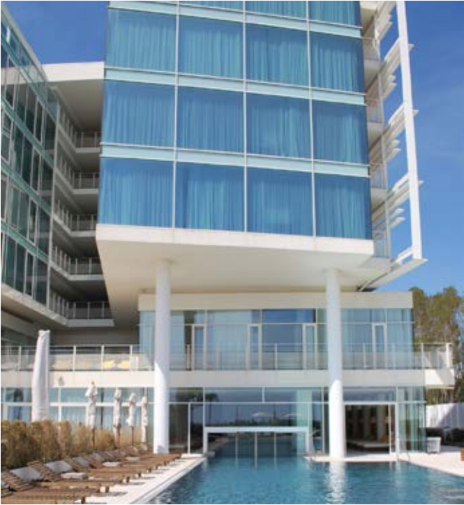
△ Pilastri compositi NPS® Slim a sezione compatta, utilizzati per il Falkensteiner Hotel di Jesolo Venezia. Progetto di Richard Meier, interior design di Matteo Thun.
