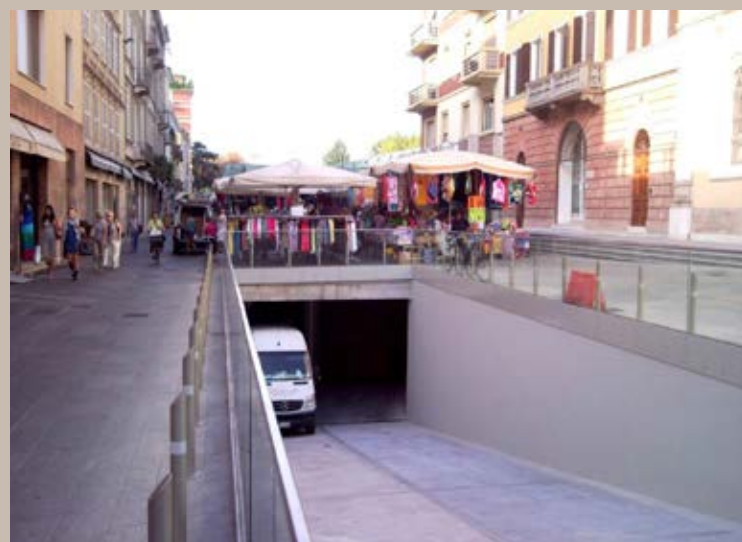
△ Prima e dopo uso della soluzione Top Down NPS® per parcheggio interrato di Piazza Ghiaia a Parma.
