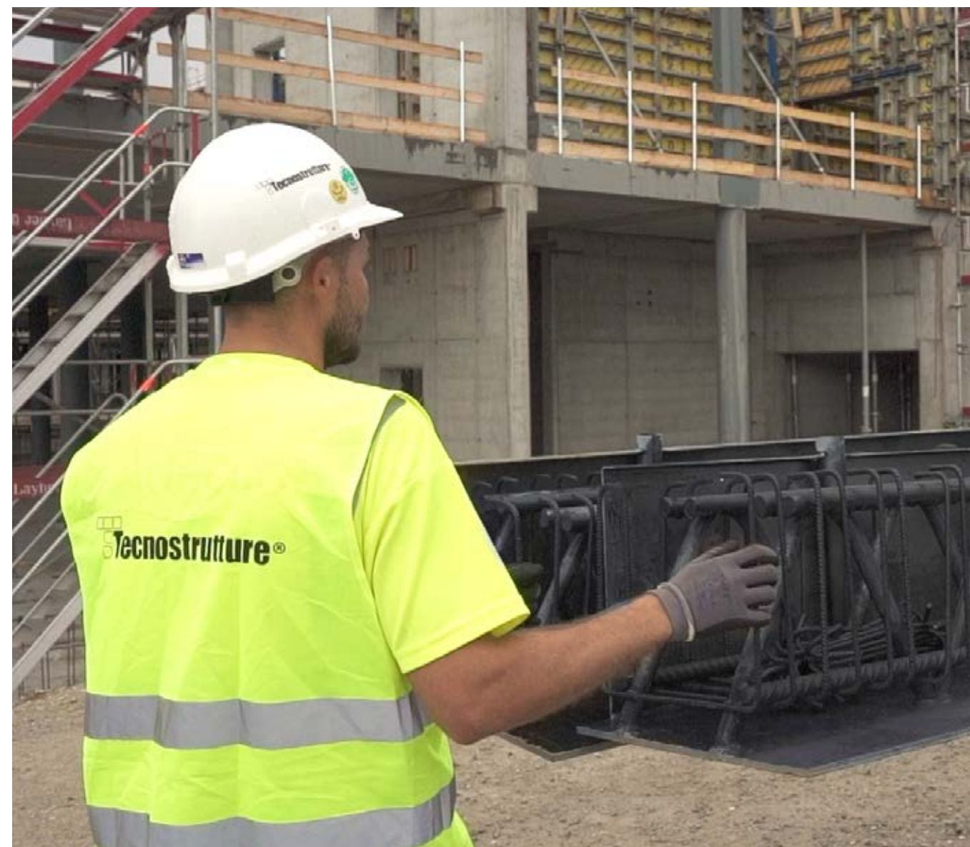
△ Indicazioni di montaggio da parte di uno dei nostri responsabili di cantiere, che coordina la squadra di installazione dell'azienda.
