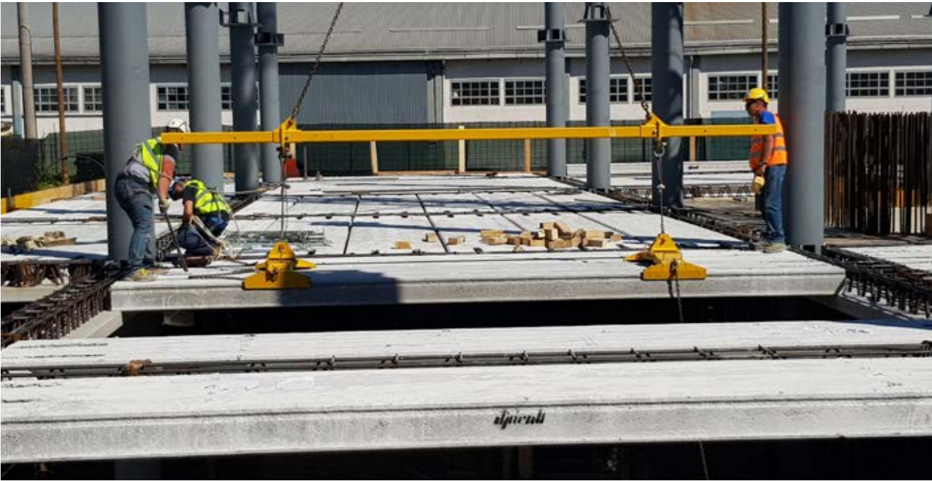
△ Cantiere ordinato e con poco personale necessario per la posa.
