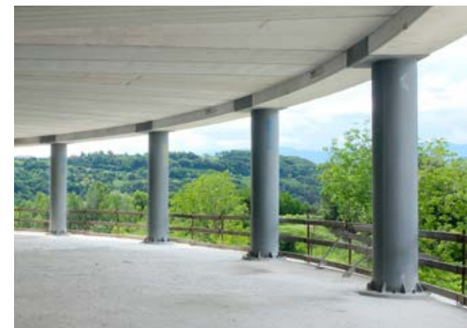
△ Trave NPS® Cls ad arco, che si adatta al perimetro circolare della struttura.
