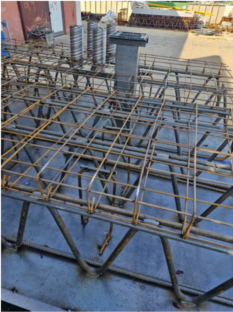
△ Solaio NPS® Strong per Megasider a Saragozza.
