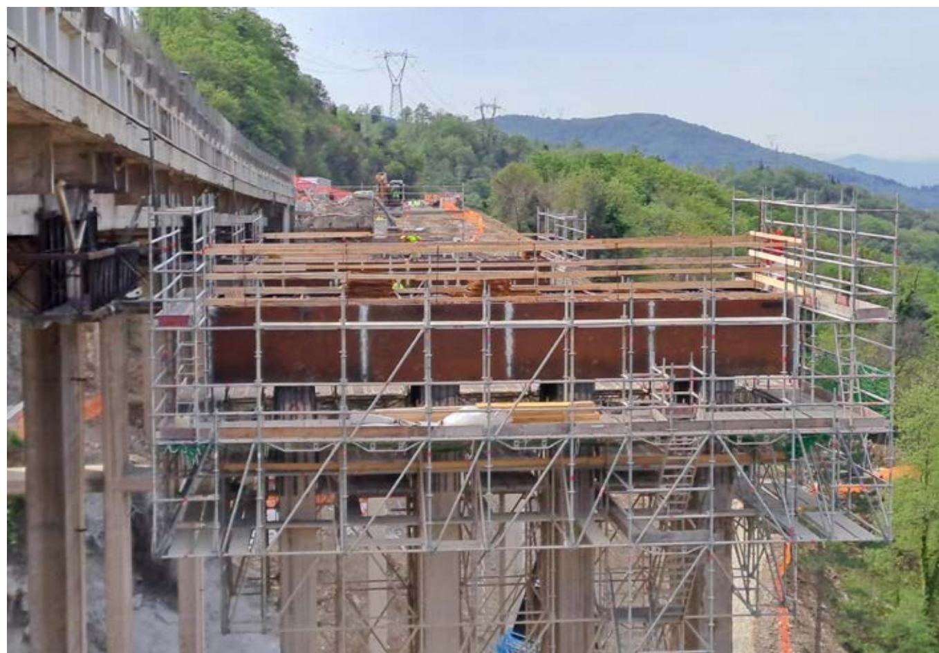
△ Pulvini su Viadotto Torracchia – Autostrada A1 MI-NA.
