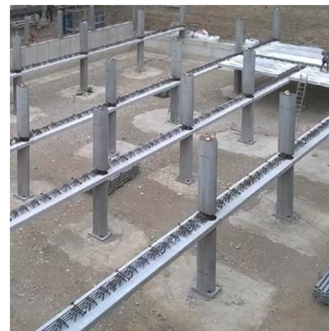
△ Le travi NPS® Cls appoggiate su pilastri NPS® Slim hanno consentito l'abbinamento a solai alveolari lunghi oltre 14 metri.
