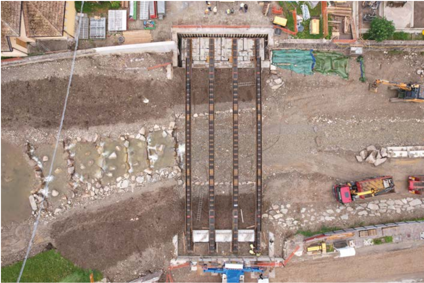
△ Il nuovo ponte a campata unica di 25,6 metri e sezione di 11 metri di larghezza.
