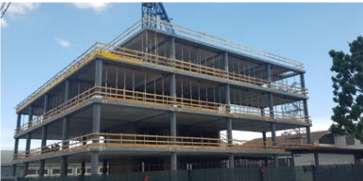
△ Realizzazione delle strutture con l'impiego di pilastrini NPS® Slim e di Travi NPS® Basic.
