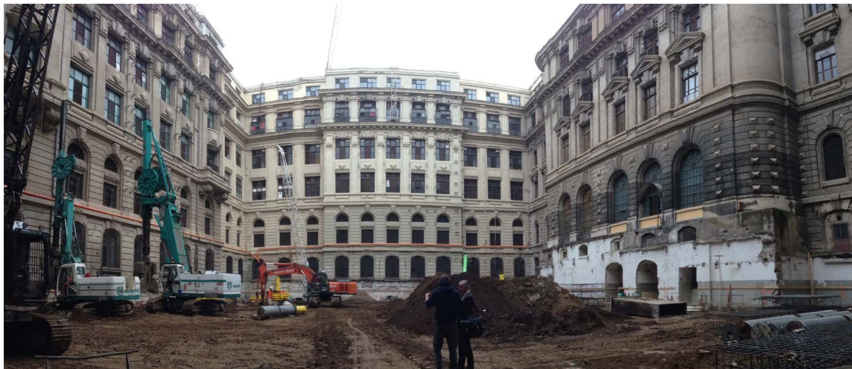
△ Vista dei lavori in Top-Down NPS® Zenith del parcheggio interrato di Piazza Verdi a Roma, circondato da un imponente edificio esistente.
