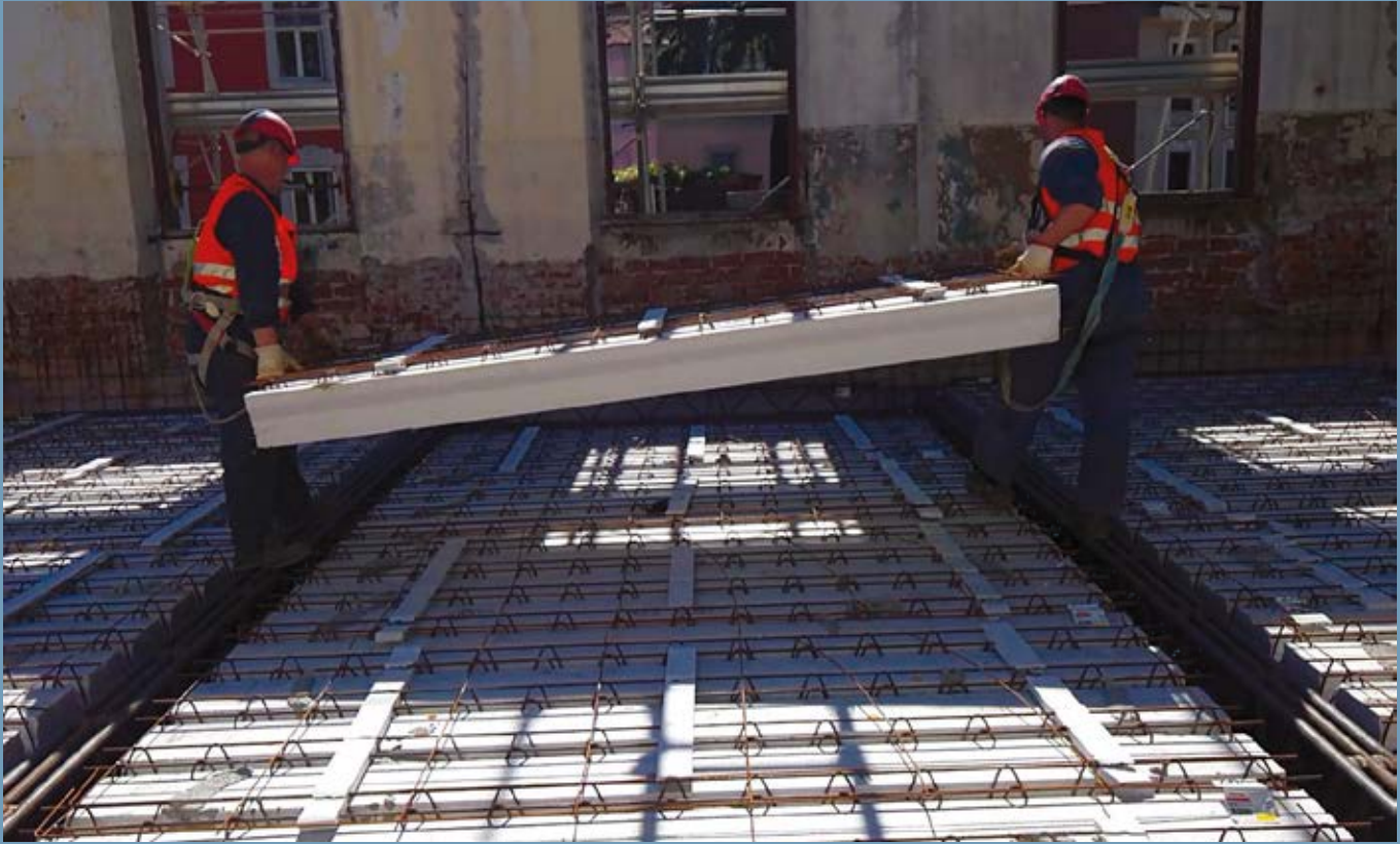
△ Grazie al suo peso a secco Airfloor® consente la facile movimentazione in cantiere.
