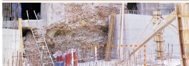
FRONTE SCAVO CON INIZIO DELLA NUOVA COSTRUZIONE
