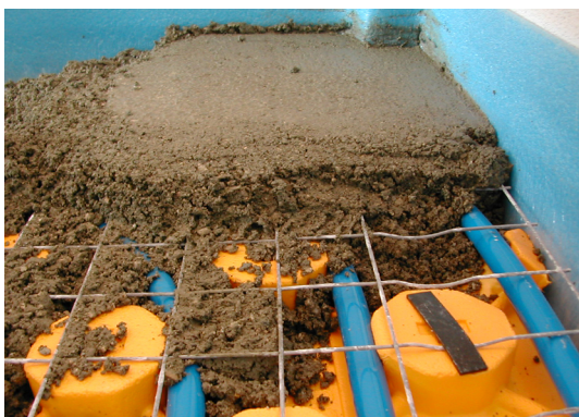
Figura 1. Esempio di massetto con riscaldamento
