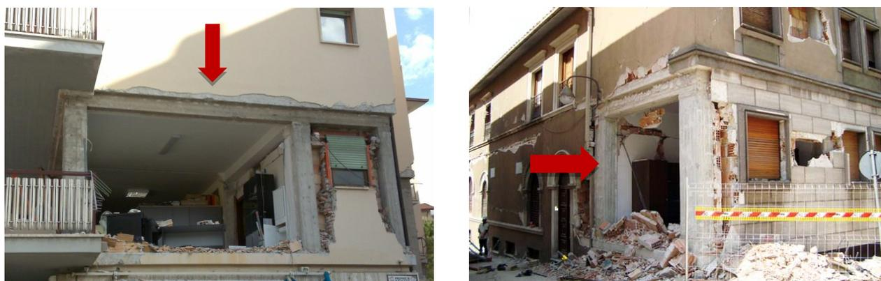
*Fig. 1: Crollo dei tamponamenti esterni a seguito del terremoto dell’Aquila del 2009.*
