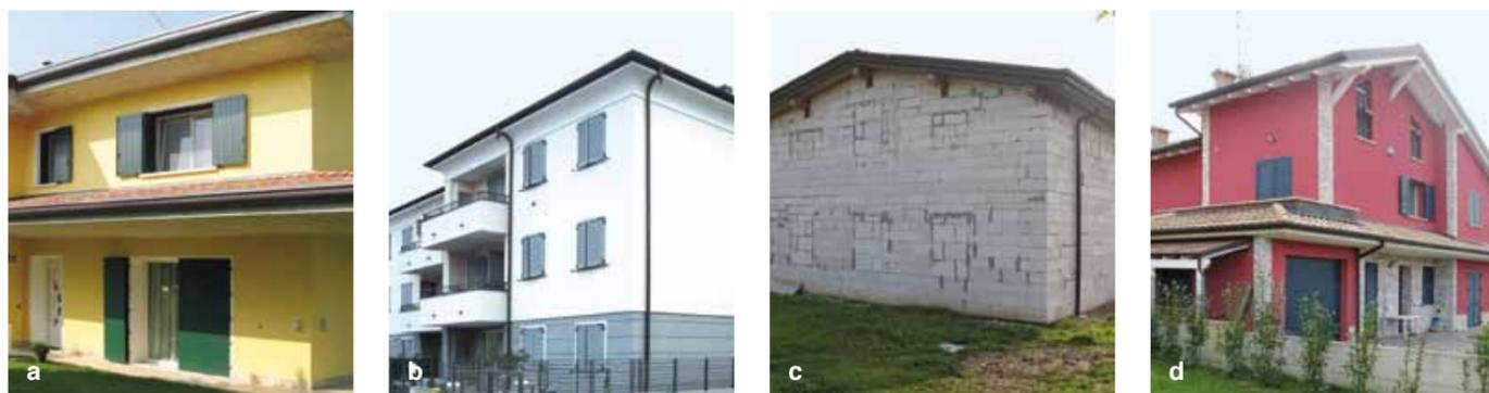
Esempi di edifici non danneggiati dagli eventi sismici: a) edificio a due piani in muratura ordinaria di laterizio nella frazione di Cassoni di Sopra nel comune di Finale Emilia; b) Edificio in muratura armata di laterizio a tre piani a S. Felice sul Panaro; c) edificio ad un piano in muratura ordinaria realizzato con blocchi in calcestruzzo aerato autoclavato nel comune di Carpi; d) edificio in muratura armata con blocchi in calcestruzzo con aggregati leggeri, ubicato a Vigarano Mainarda.
