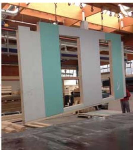
IM2 - Il sistema costruttivo "platform frame" del progetto è stato modellato nella sua essenza costruttiva, suddividendo il modello BIM in "sub-assemblies" che simulano i componenti effettivamente prefabbricati generando gli elaborati esecutivi per ogni parete strutturale, utili ai fini costruttivi e di calcolo strutturale delle pareti, trasferite poi senza possibilità di errori o modifiche sostanziali agli stabilimenti di produzione CAM e assemblaggio di Rubner Haus (Chienes, BZ).
