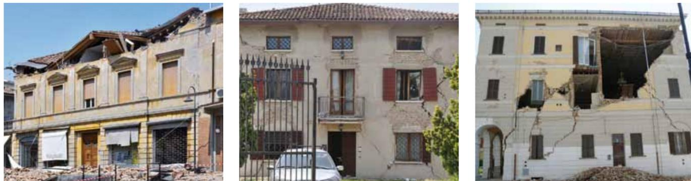
A sinistra: Collapsi parziali fuori piano di facciate in muratura causati da coperture in legno spingenti nel centro storico di Concordia sulla Secchia. Al centro: Edificio in cui il danno nel piano è concentrato nei maschi murari e nelle fasce (Rovereto sulla Secchia). A destra: un'immagine del municipio di Sant'Agostino, gravemente danneggiato (rilievo del 30 maggio 2012).
