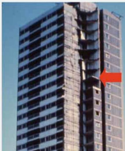
Figura 3. Collasso progressivo di un angolo della torre di Ronan Point con l'ambiente luogo dell'esplosione di gas al 16° piano
