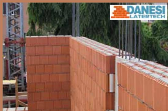
L'utilizzo dell'innovativo blocco ThermoKappa di Danesi ha permesso la realizzazione di un edificio residenziale a elevate prestazioni termiche ed energetiche senza ricorrere all'applicazione di un sistema di isolamento a cappotto o di un termointonaco
