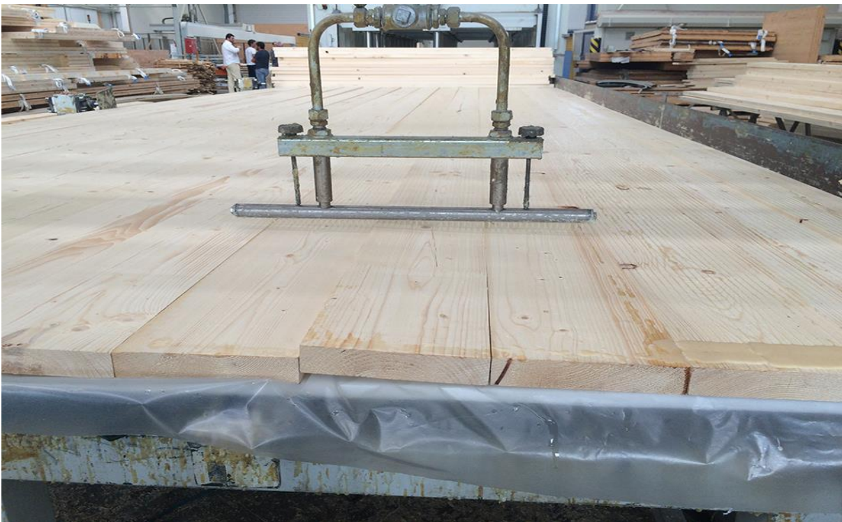
Pannello in fase di incollaggio
