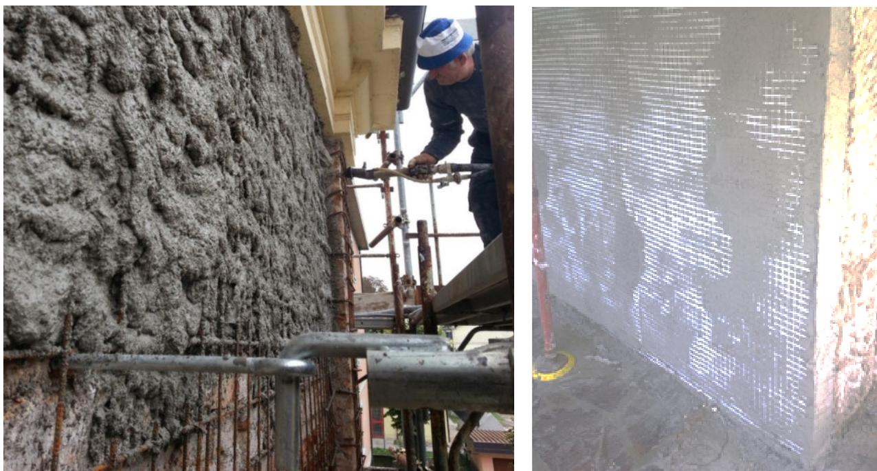
***Figura 4: Rinforzo strutturale mediante placcaggi in betoncino cementizio armato***
