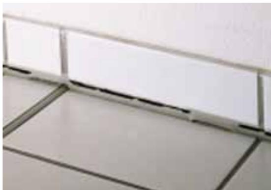
Figura 1 - Distacco delle fughe siliconiche perimetrali
