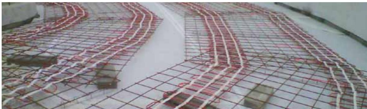
Il **MAT SYSTEM** è la soluzione ideale per risolvere il problema del ghiaccio e della neve sulle rampe carrabili, i vialetti pedonali, le piazze, gli eliporti, ecc. tramite sistema a tappeto con cavo scaldante, a potenza costante, per esterni.
