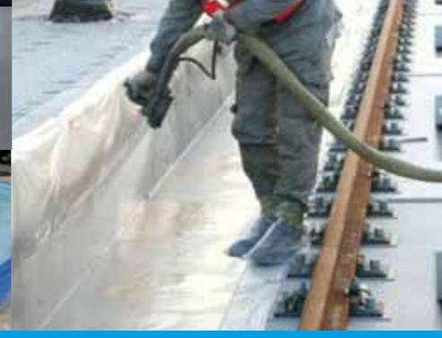
MEMBRANA LIQUIDA, BICOMPONENTE, ELASTICA, IN POLIUREA PURA VAPORIZZATA A CALDO
