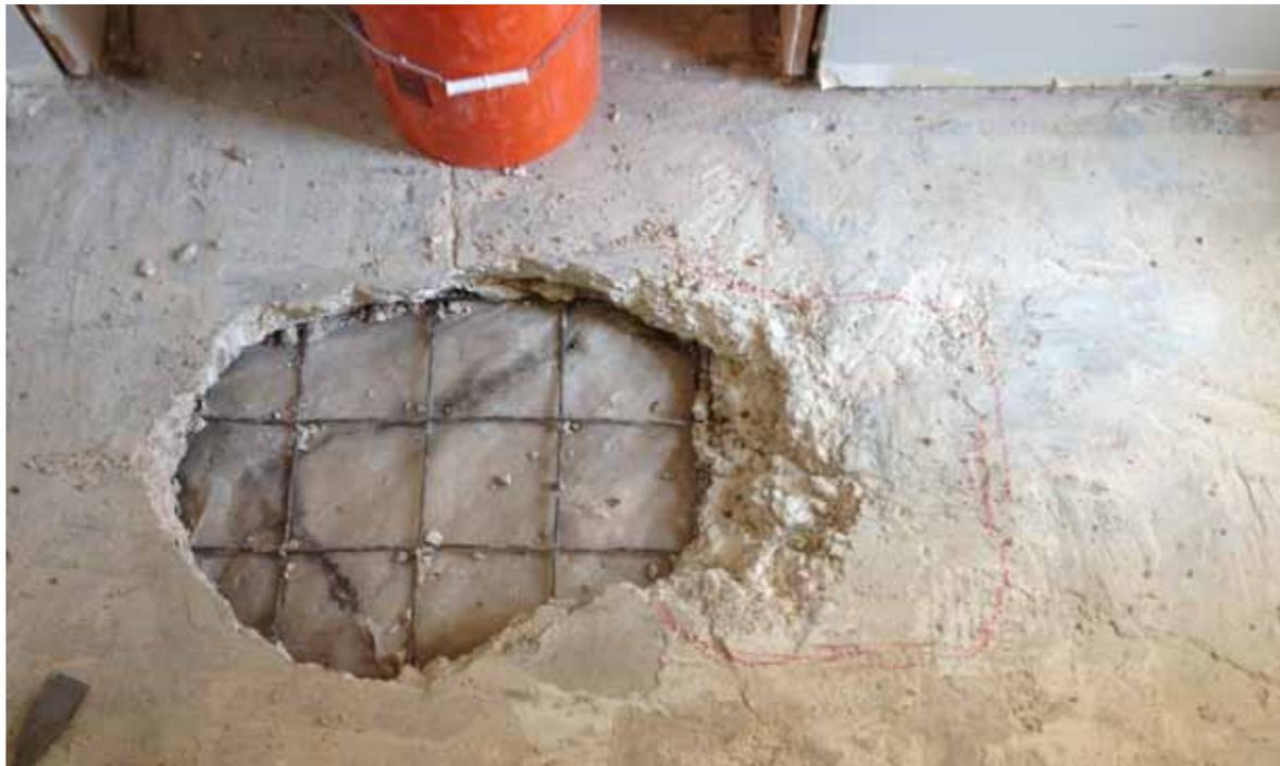
Figura 3 - Immagine di un massetto non perfettamente coeso alla superficie
