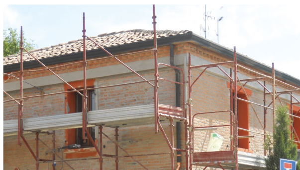
Visione di insieme dell'intervento: cerchiatura eseguita in sommità e in corrispondenza del solaio.
