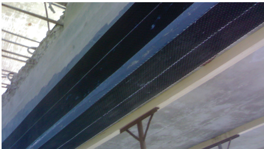
Applicazione dei tessuti in fibra di carbonio ARMOSHIELD-C all'intradosso della trave.
