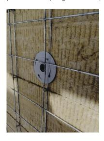
La finitura dei pannelli di Karma® può essere regizzata con diverse tipologie di materiale: la rete porta intonaco pre saldata nei singoli moduli permette sia l'intonacatura armata che il rivestimento con mattoni faccia vista, pietra naturale, pietra ricostruita o ceramica.
