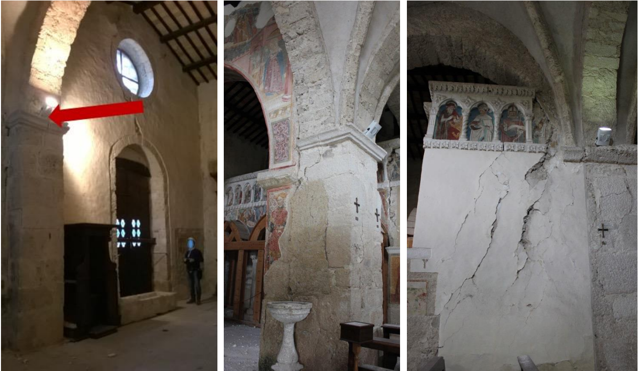
Figura 24. Lesioni presenti sui tre pilastri centrali più vicini alla facciata, a seguito del 24 agosto 2016: (a) Primo pilastro, addossato alla facciata, sulla cui sommità agisce la spinta della volta a crociera. (b) Secondo pilastro. (c) Terzo pilastro adiacente all'iconostasi. Da notare qui come la spinta orizzontale della volta in fase sismica si è scaricata a terra attraverso la parete laterale dell'iconostasi.
