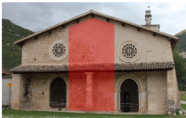
Figura 29. (a). Porzione della facciata della chiesa di San Salvatore. (b) Sezione longitudinale della chiesa di San Salvatore con indicata la spinta proveniente dal peduccio della volta a crociera, che si scarica sulla facciata.
