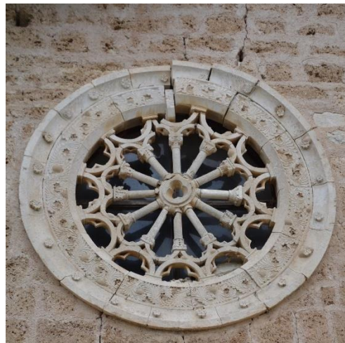
Figura 25. Stato di danno della chiesa di San Salvatore dopo il terremoto del 24 agosto 2016. (a) Danneggiamento del parapetto dell'iconostasi, prossimo al collasso. (b) Danneggiamento del rosone di sinistra con alcuni conci sconnessi.
