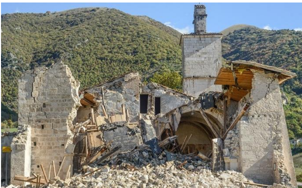
Figura 27. Stato di danno della chiesa di San Salvatore dopo le scosse del 26 ottobre 2016. (a) Vista frontale della chiesa, immagine tratta da [16]. (b) Lesioni presenti sul muro laterale di destra (immagine tratta da un video dell'Ing. R. Vetturini). Da notare come la spinta in avanti legata alla massa delle volte a crociera si è scaricata a terra dando origine a dei puntoni diagonali sulla muratura perimetrale. Non ci sono puntoni diretti in modo inverso perché la presenza (sul retro della chiesa) del campanile, molto tozzo, ha impedito il movimento all'indietro delle volte.
