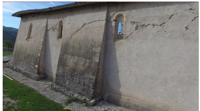
Figura 27. Stato di danno della chiesa di San Salvatore dopo le scosse del 26 ottobre 2016. (a) Vista frontale della chiesa, immagine tratta da [16]. (b) Lesioni presenti sul muro laterale di destra (immagine tratta da un video dell'Ing. R. Vetturini). Da notare come la spinta in avanti legata alla massa delle volte a crociera si è scaricata a terra dando origine a dei puntoni diagonali sulla muratura perimetrale. Non ci sono puntoni diretti in modo inverso perché la presenza (sul retro della chiesa) del campanile, molto tozzo, ha impedito il movimento all'indietro delle volte.
