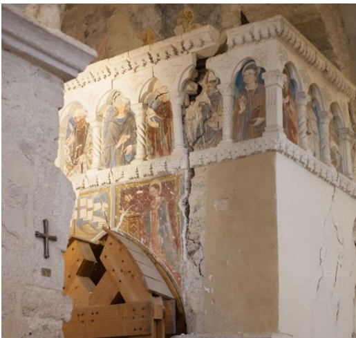
Figura 25. Stato di danno della chiesa di San Salvatore dopo il terremoto del 24 agosto 2016. (a) Danneggiamento del parapetto dell'iconostasi, prossimo al collasso. (b) Danneggiamento del rosone di sinistra con alcuni conci sconnessi.
