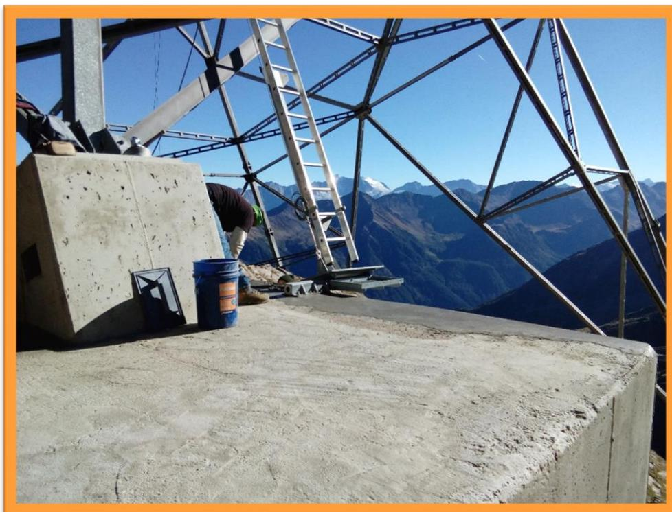
**Ripristino volumetrico a profilo originale mediante applicazione di malta MORTAR TIX CRYSTAL.**
