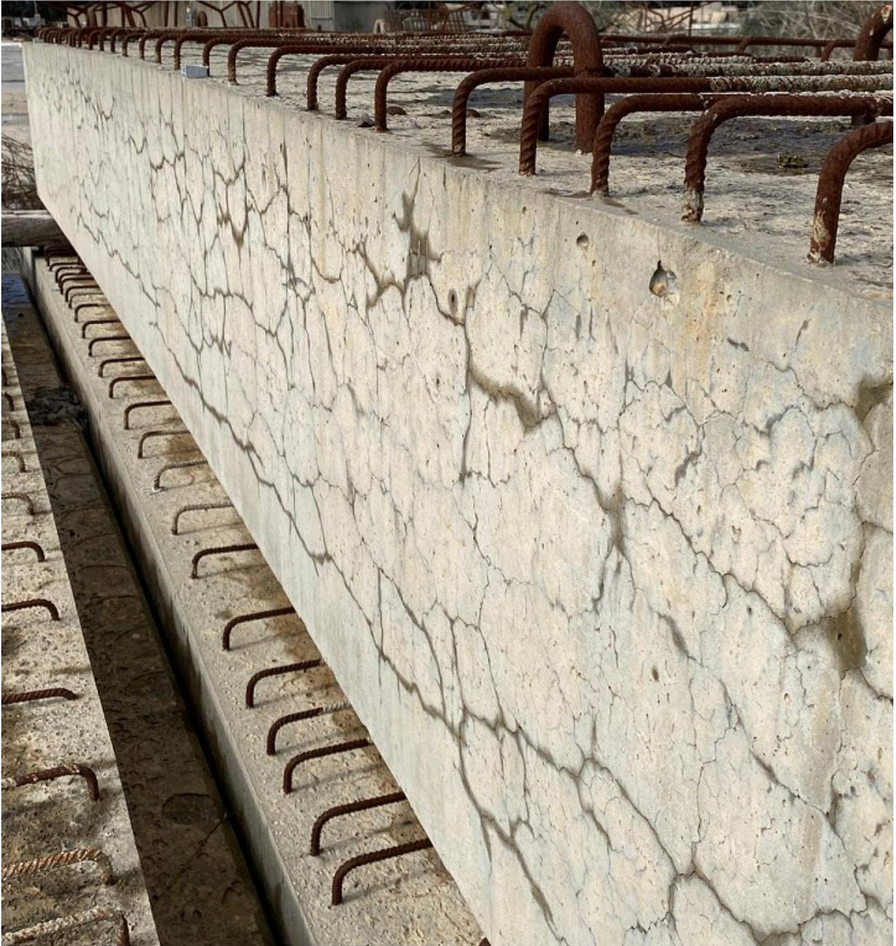
**Figura 2** – Degrado da probabile attacco solfatico in una trave realizzata in uno stabilimento del sud America
