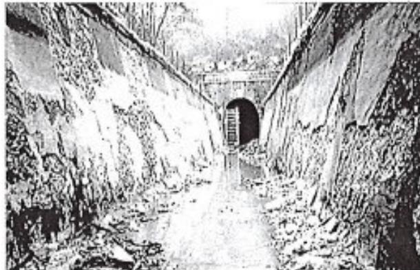
Fig.10.18 - Pareti di un canale in calcestruzzo dopo la rimozione di acqua solfatica
