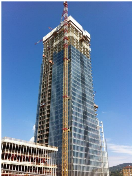
Fig. 27 – Nuovo Palazzo per Uffici Torre Regione Piemonte, Torino
