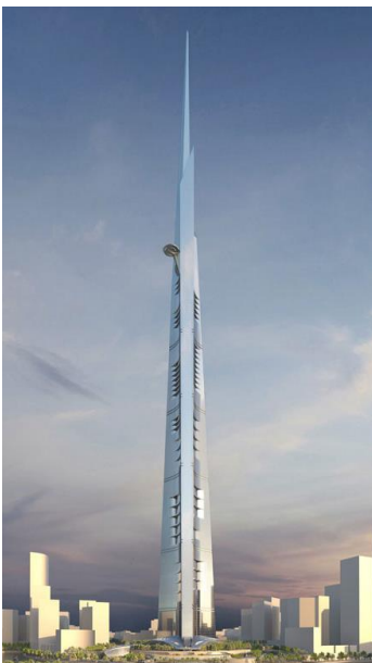
Fig. 19 – Kingdom Tower, Jeddah (in costruzione)
