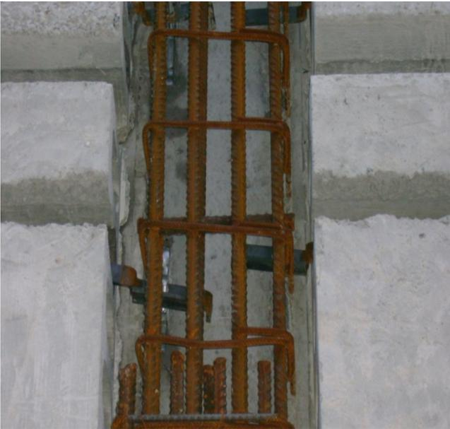
*Dettaglio fissaggio lastre alveolari agli archi*
