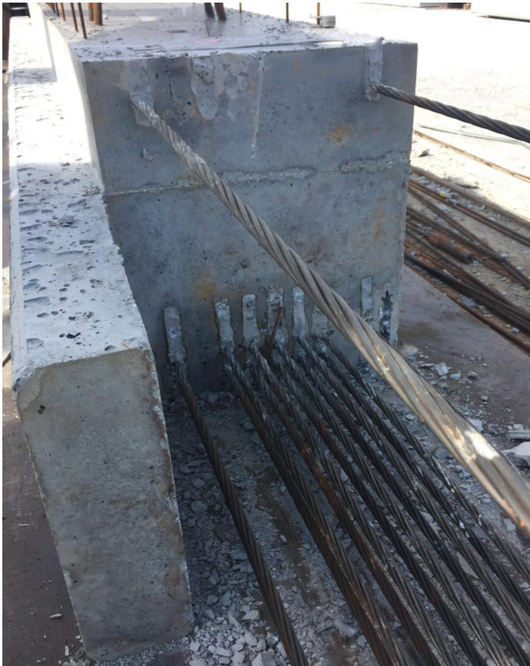
Figura 6: Dettaglio trave in Rck55 con trefoli da 6/10" i quali, a circa 20 ore dal getto, vengono dapprima rilasciati e poi tagliati per imprimere – per aderenza – la presollecitazione. Ogni cavo porta circa 19 tonnellate!
