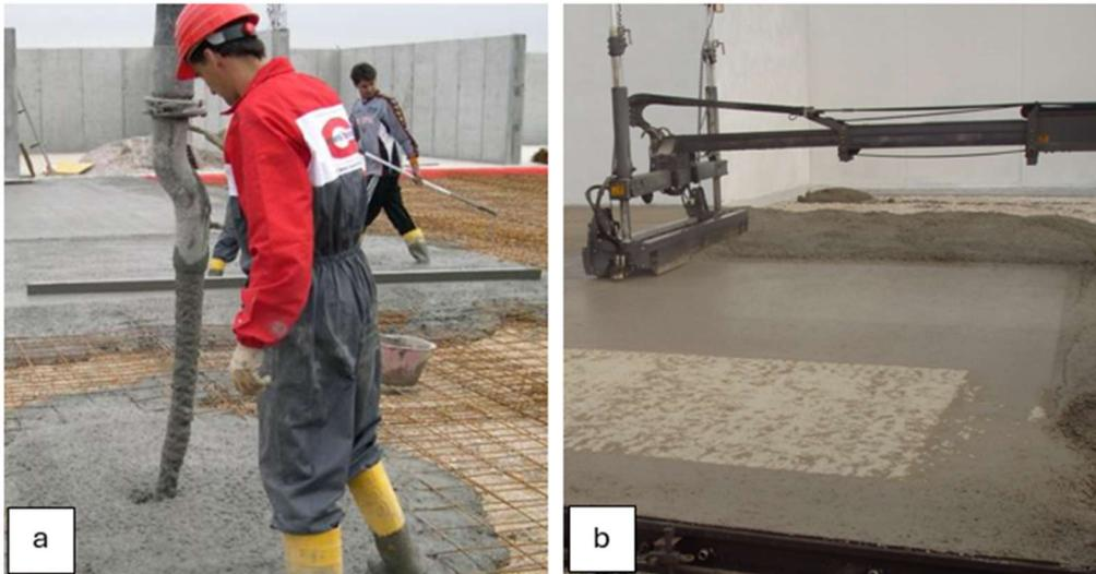
**Figura 1** – Consistenza del calcestruzzo in funzione della modalità di posa in opera
