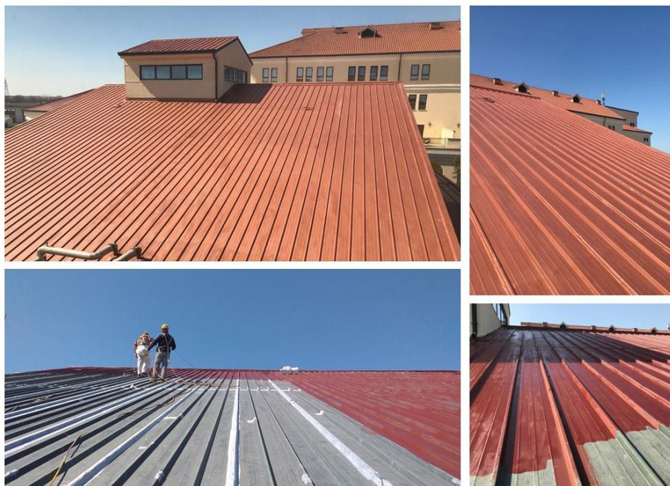
*Intervento di ripristino mediante sistema Icobit: Keep Dry Metal su supporto metallico esistente*
