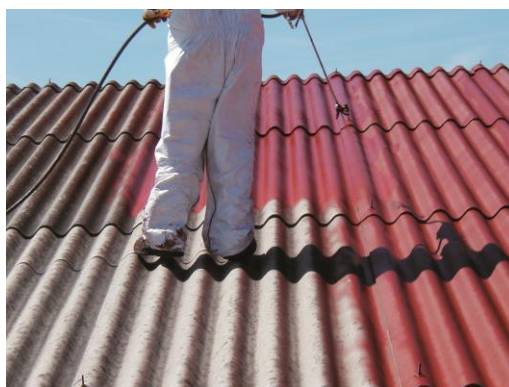
Figura 3 - Applicazione ad airless dei sistemi impermeabilizzanti Icobit
