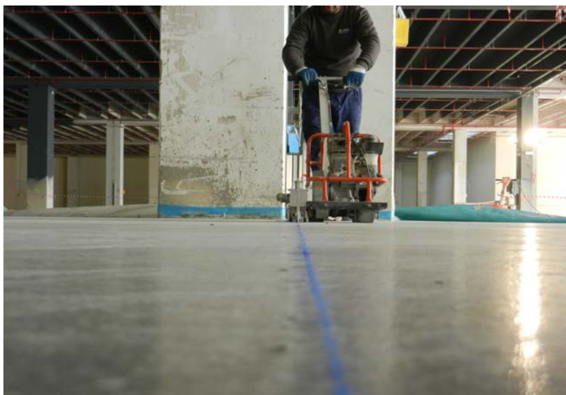
Fig. 21 – Esecuzione di un giunto di contrazione
