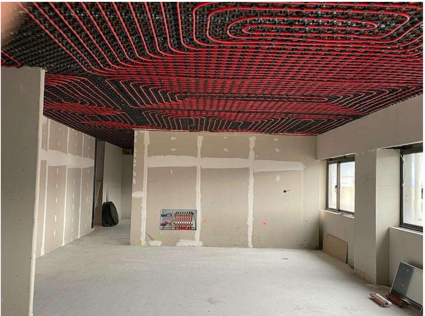
*Sistema radiante UNI EN 1264 a bassa inerzia termica installato a soffitto*
