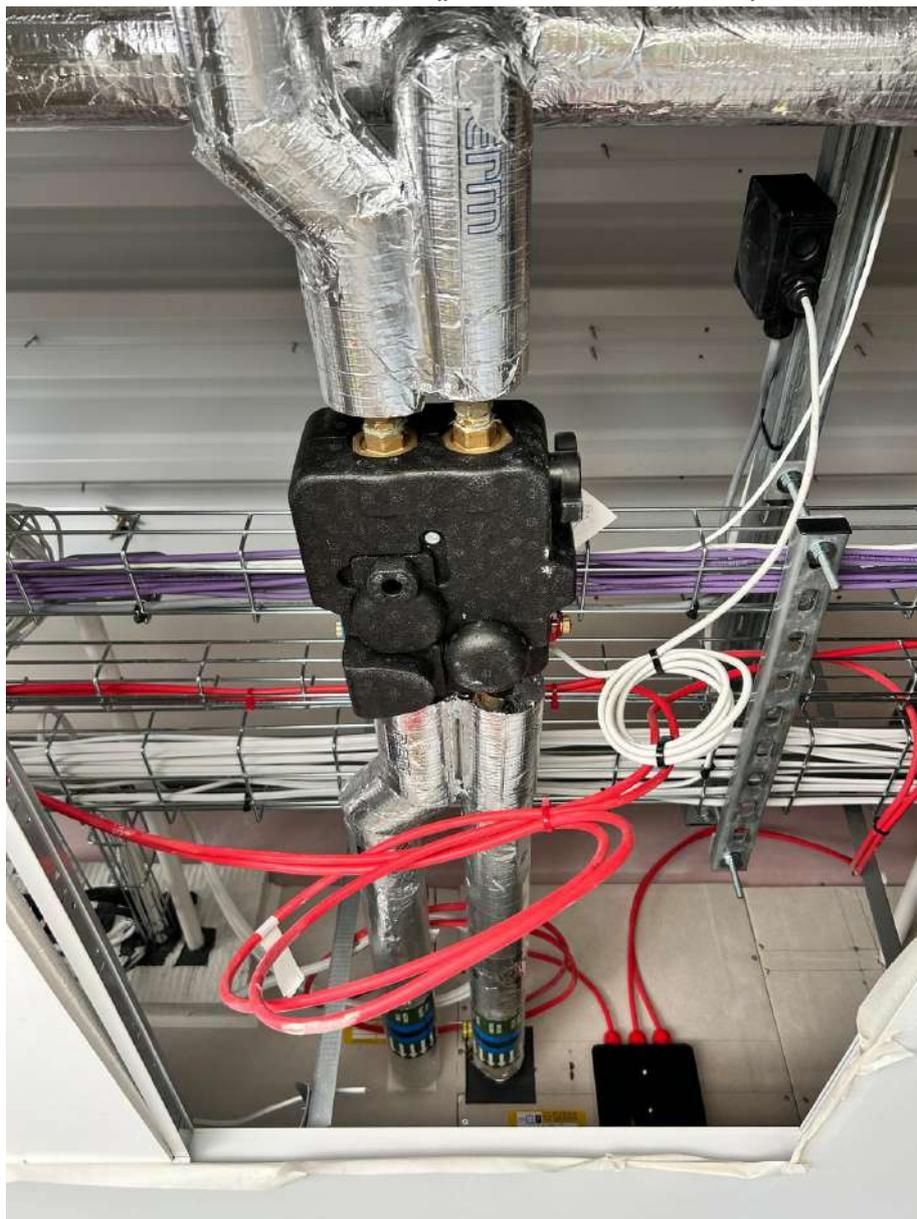
*Installazione di fan coil R280KC in controsoffitto ispezionabile*
