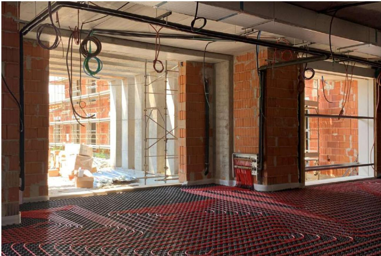
*Sistema radiante UNI EN 1264 a bassa inerzia termica installato a pavimento*
