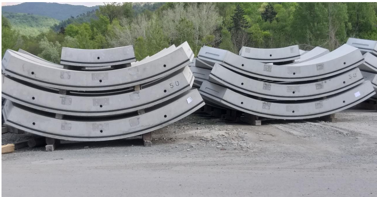
Figura 3. Fase di stoccaggio di conci prefabbricati
