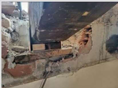
Fig.12 – Dettaglio appoggio.
