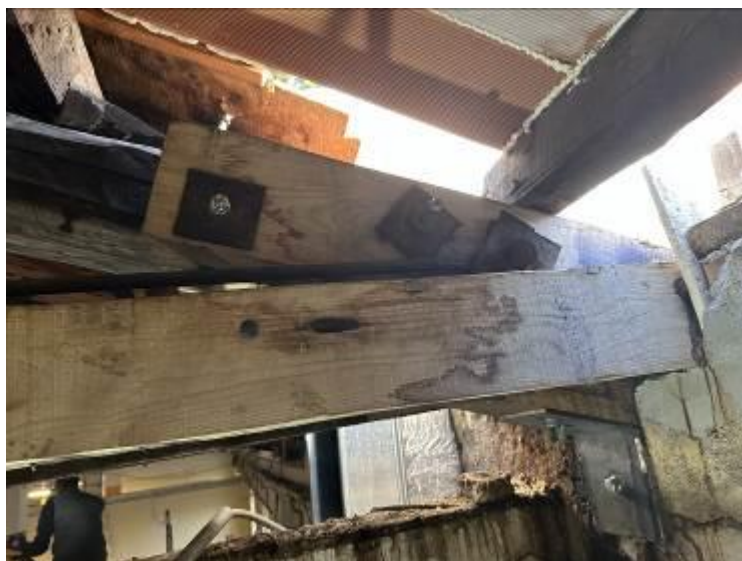
Fig.16 – Vista laterale della ricostruzione totale della testata e dell'appoggio.
