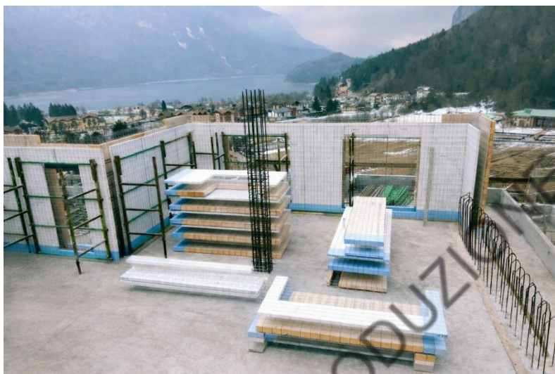
Organizzazione del cantiere
