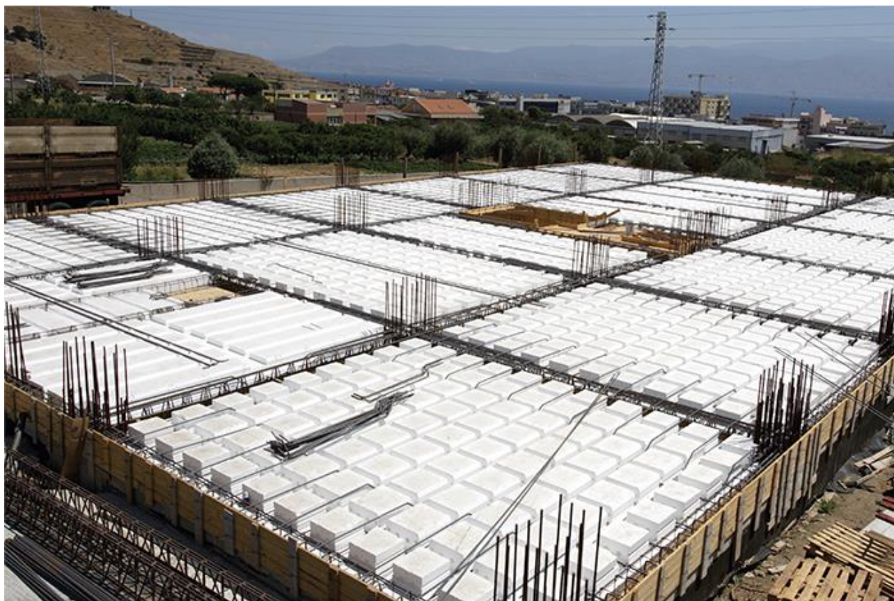
Figura 1: Realizzazione di un ampio solaio tramite il Sistema Cube di SCF.
