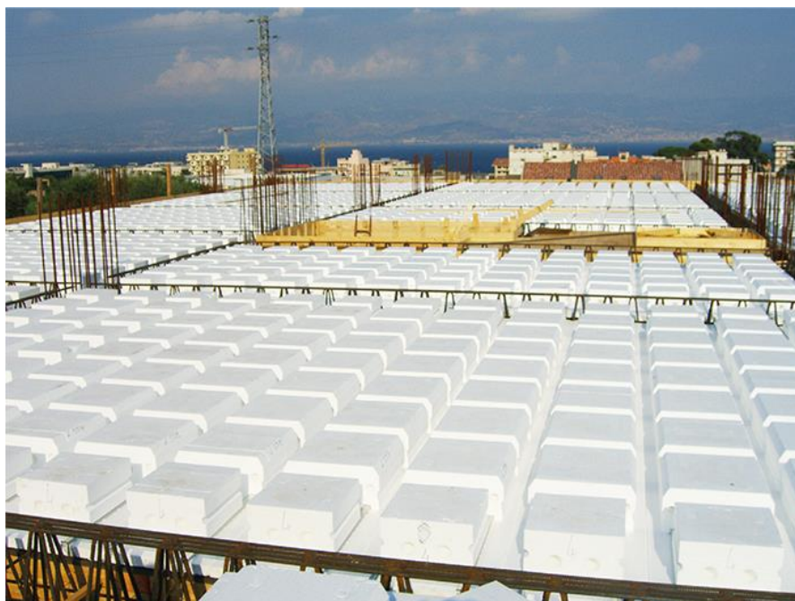
Figura 4: Vista di un cantiere in costruzione con il Cassero Cube®.
