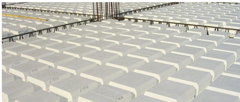
Figura 5: Dettaglio della continuità del montaggio del Cassero Cube®.
