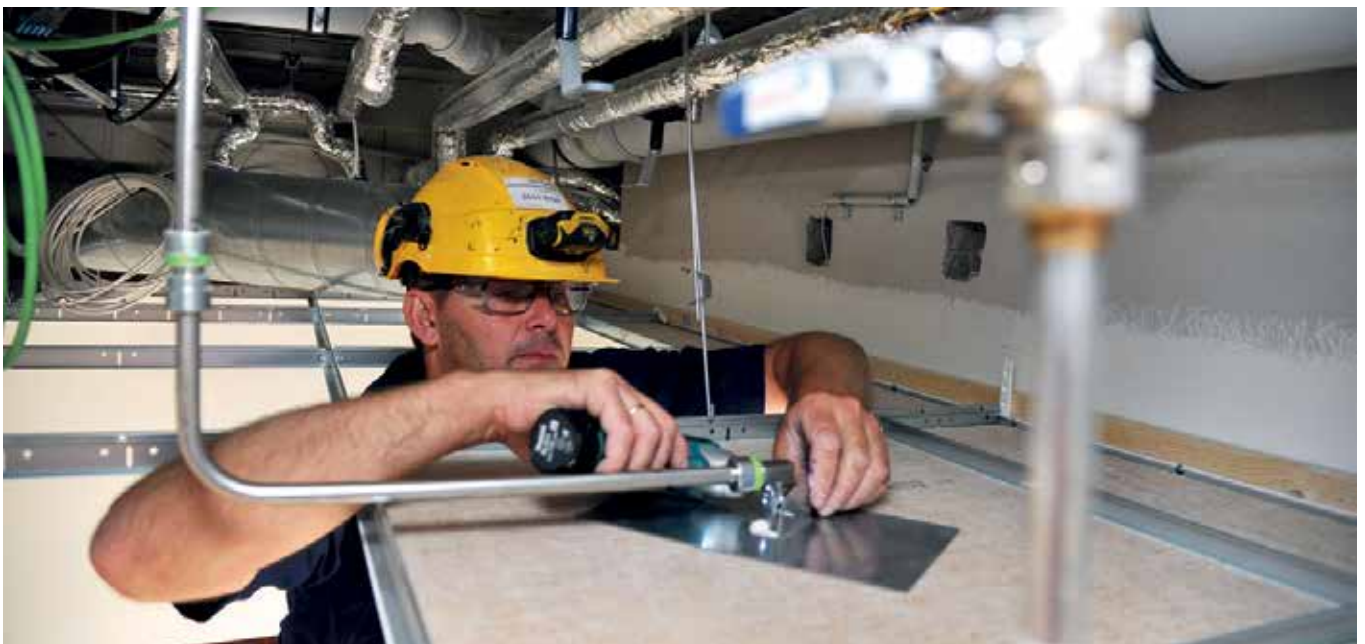
Installazione rapida e semplice dell'erogatore water mist ad alta pressione SEM-SAFE®.
