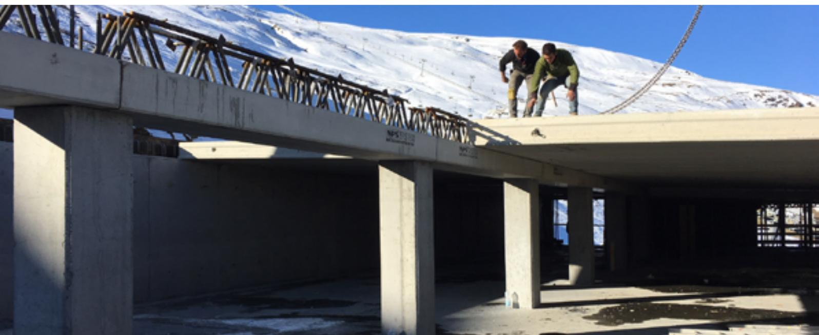
Per la realizzazione della stazione intermedia della nuova cabinovia *Carosello 3000*, sono state **impiegate travi NPS® CLS su due solai da 1250mq cadauno** e *Tecnostрукture* si è occupata della progettazione esecutiva e di quella produttiva, servizi sempre inclusi nella fornitura di elementi NPS®.
