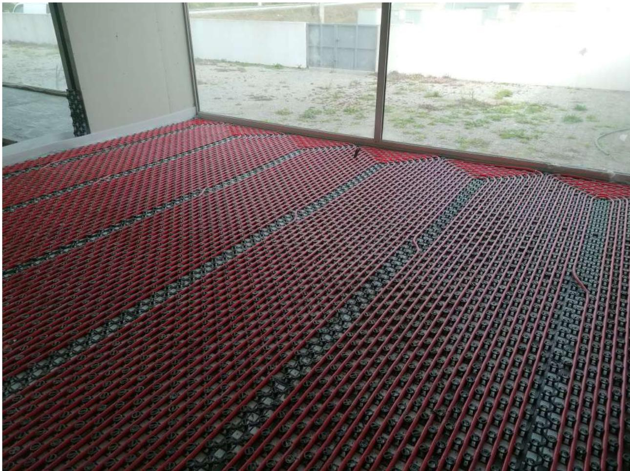
*Fig. 2 – Sistema radiante a bassa inerzia termica installato a pavimento*
