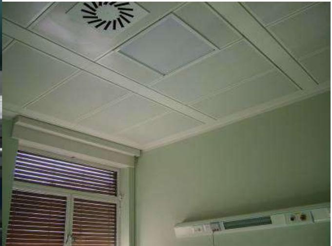
*Fig. 7 – Installazioni ospedaliere a soffitto radiante*
