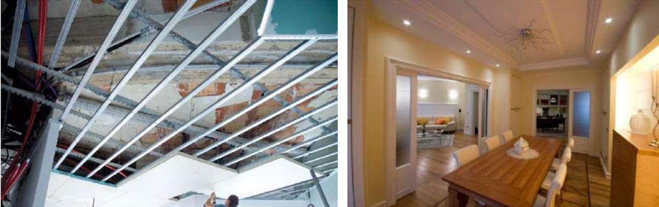
*Fig. 4 – Soffitto radiante a bassa inerzia termica realizzato con pannelli in cartongesso*
