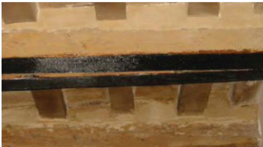
Applicazione dei tessuti in fibra di carbonio ARMOSHIELD C-SHEET all'intradosso della trave.
