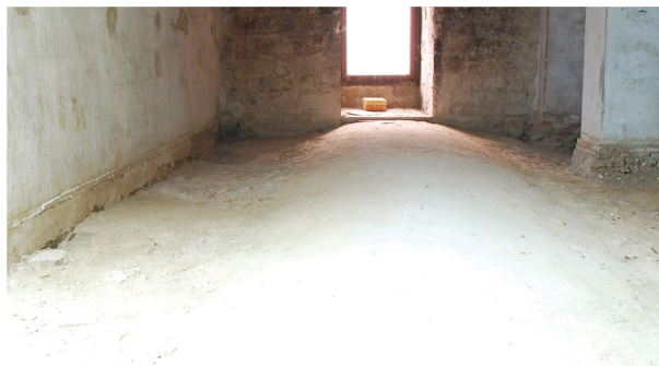
Volta a botte prima dell'intervento: rimozione del rivestimento superficiale.
