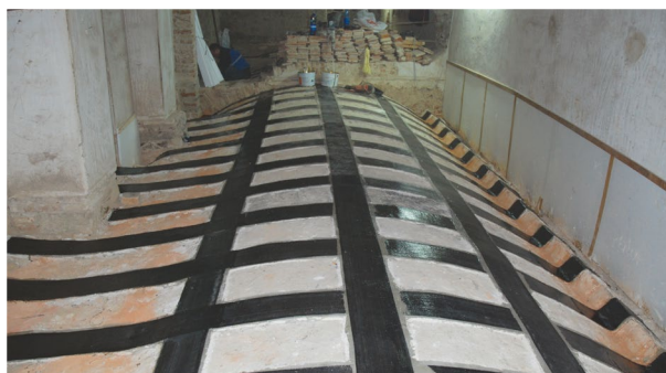
Esempio di applicazione all'estradosso.
