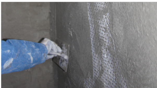
Applicazione della rete tra due strati di malta ARMOTECH MONO.
