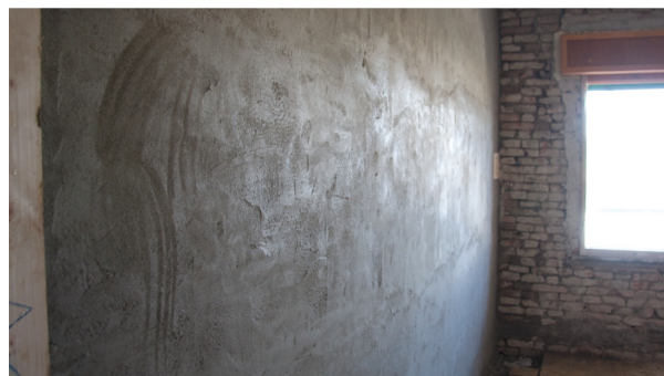
Intervento di rinforzo antiribaltamento ultimato.
