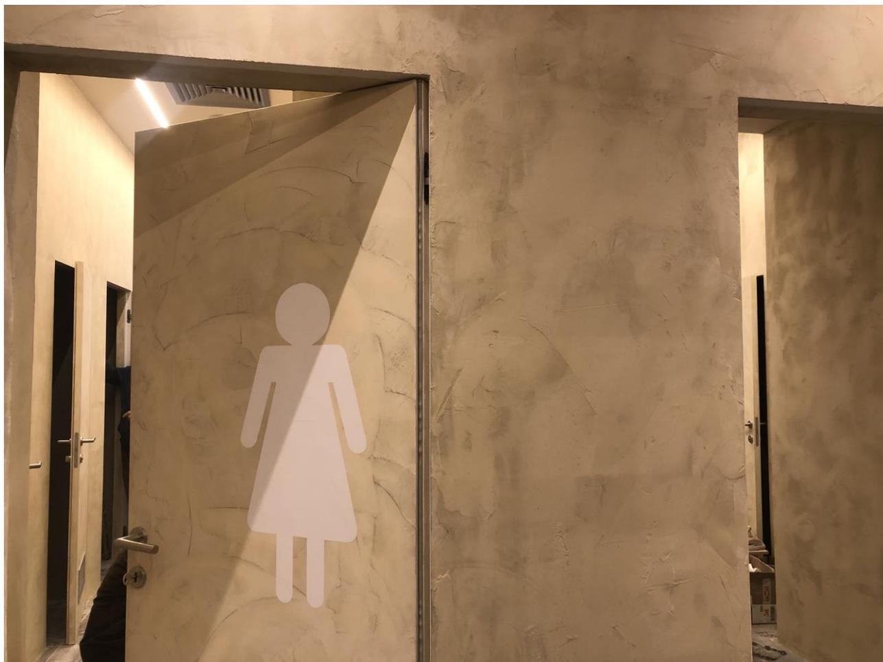
**Figura 3** - Rivestimento delle pareti dei bagni dell'Outlet Castel Guelfo (BO) con Materica serie Invidia. Particolare dell'effetto "Nuvolato" creato dall'applicazione a spatola.
