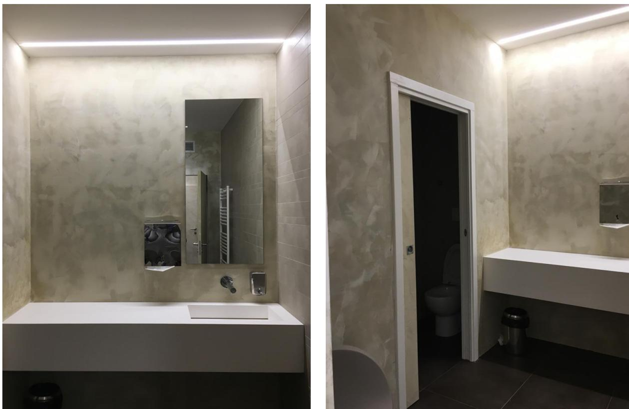
**Figura 4** – Particolari del rivestimento dei bagni dell'Outlet Castel Guelfo (BO) con Materica serie Invidia.
