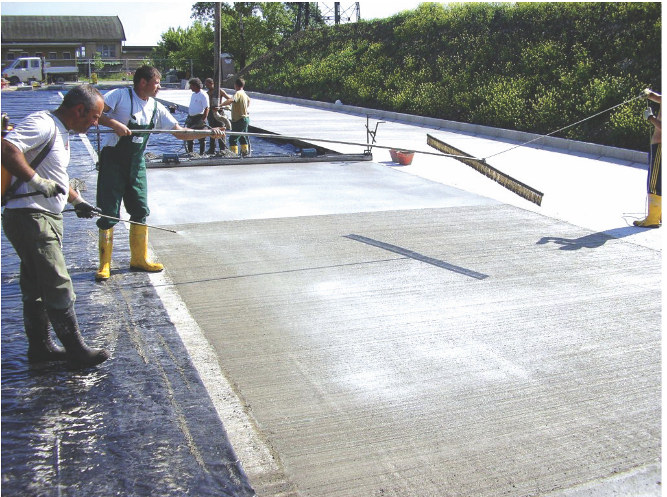
Applicazione a spruzzo di PROBETON CURING N.
