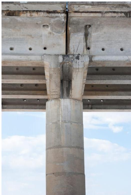
*Esempio di patologia del c.a. dovuta alle macchie di umidità*
