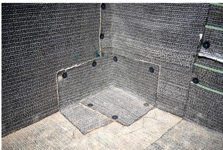
*Telo bentonitico Voltex CR applicato in struttura interrato*
