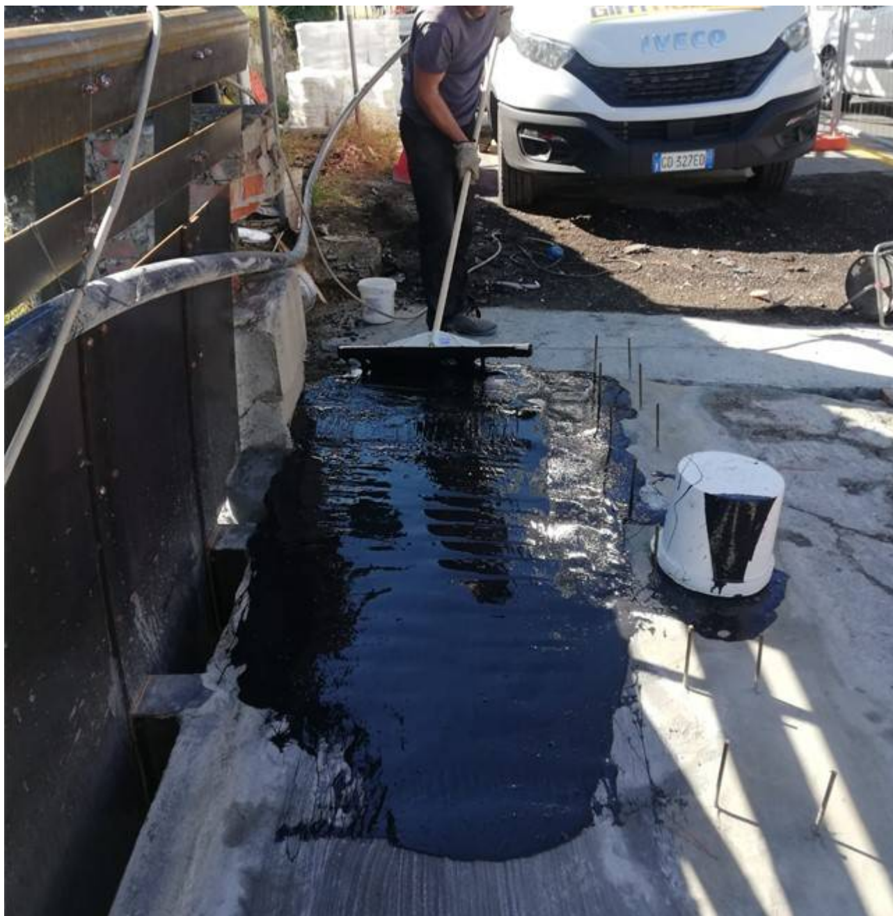
Applicazione del rivestimento epossipoliuretano Elastoproof, per l'impermeabilizzazione di impalcato di ponte.
