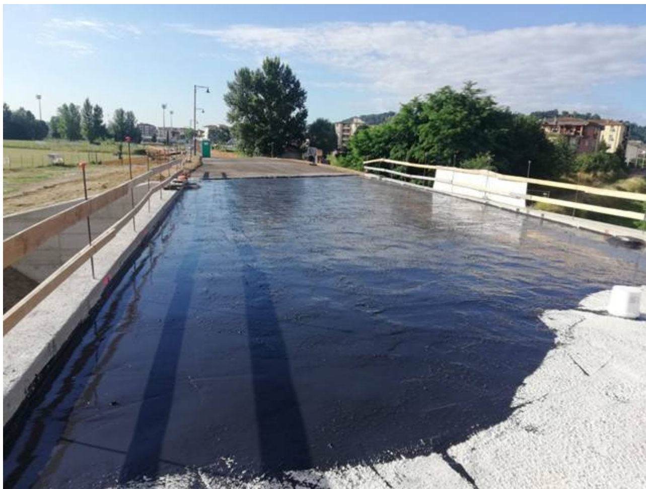
Elastoproof applicato preliminarmente allo strato di binder.
