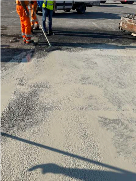
DRACOBIT - Realizzazione della pavimentazione bituminose-cementizia nel porto di Ravenna - DRACO Italiana SpA©
