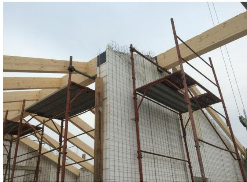
Gli elementi portanti verticali di Ecosism consentono la realizzazione di coperture 'classiche', come quella in legno con travi che rimarranno a vista, realizzata nell'abitazione di Rocchetta Tanaro. Il progetto dell'intero edificio, quindi anche delle coperture, viene seguito scrupolosamente dall'ufficio tecnico di Ecosism.
