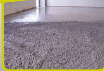
**Ruredil X Fiber 19:** la nuova generazione di sottofondi e massetti senza armatura per le pavimentazioni civili. Riduce il fenomeno di ritiro plastico evitando la formazione di fessure.
