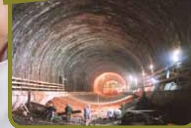
**Ruredil X Fiber 54S:** per lo *sprayed concrete* in galleria. Sostituisce la rete metallica migliorando le proprietà meccaniche e la durabilità del calcestruzzo proiettato.
