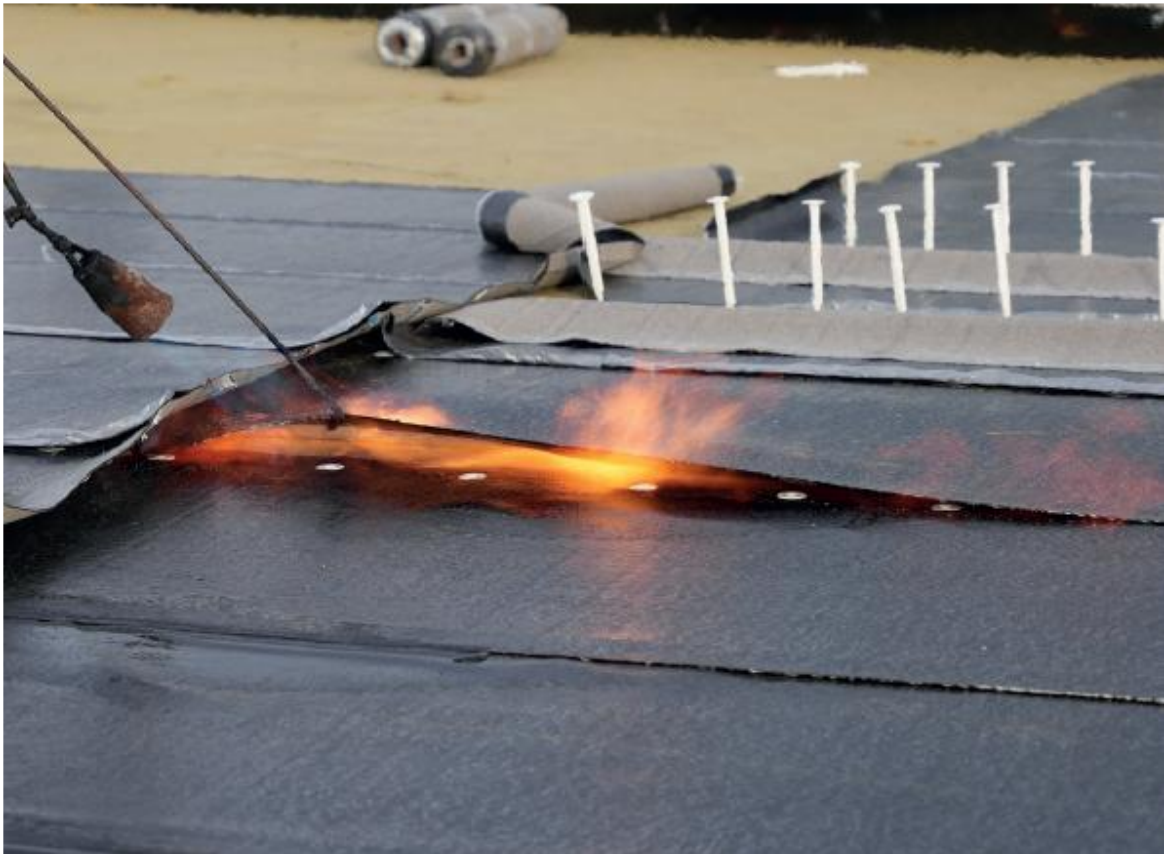
Applicazione su substrato bituminoso
