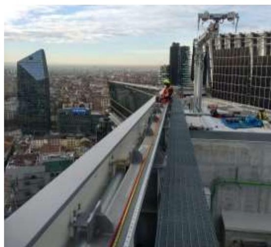
**Figura 11** –Carpenteria metallica di supporto alle facciate della vela (a sinistra) e copertura tecnica (a destra)
