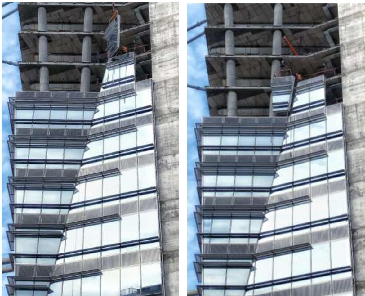
**Figura 9** – Posa della cellula d'angolo trapezoidale
