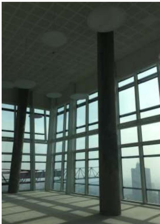
Il 23<sup>esimo</sup> piano della torre ospita uno spazio esclusivo a doppia altezza: la facciata continua è ritenuta da una carpenteria metallica con ingombri delle sezioni ridotti, in modo da massimizzare la visibilità verso l'esterno e l'ingresso della luce.
