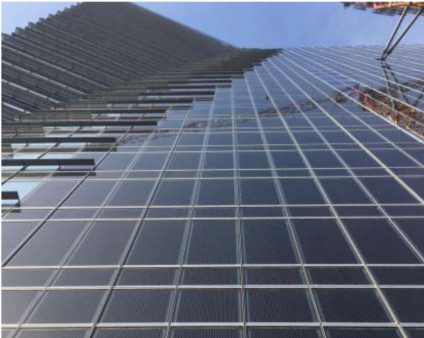
La facciata che riveste i nuclei strutturali e l'adiacente facciata tipologica a cellule, pur essendo sistemi sostanzialmente diversi, si interfacciano in maniera invisibile dall'esterno, garantendo una visione continua e fluida, senza interruzioni.
