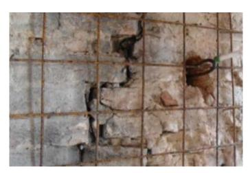
Al contrario, con la tecnica CRM il problema della corrosione delle armature viene completamente eliminato ed è possibile ridurre lo spessore dello strato d'intonaco, contenendo quindi le masse e i pesi agenti sulla struttura.
