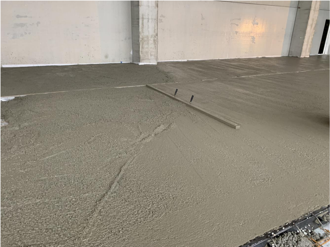
Figura 8. Fasi di getto e stesura della pavimentazione fibrorinforzata con FIBRAG® POLY: PSF 55-TP
