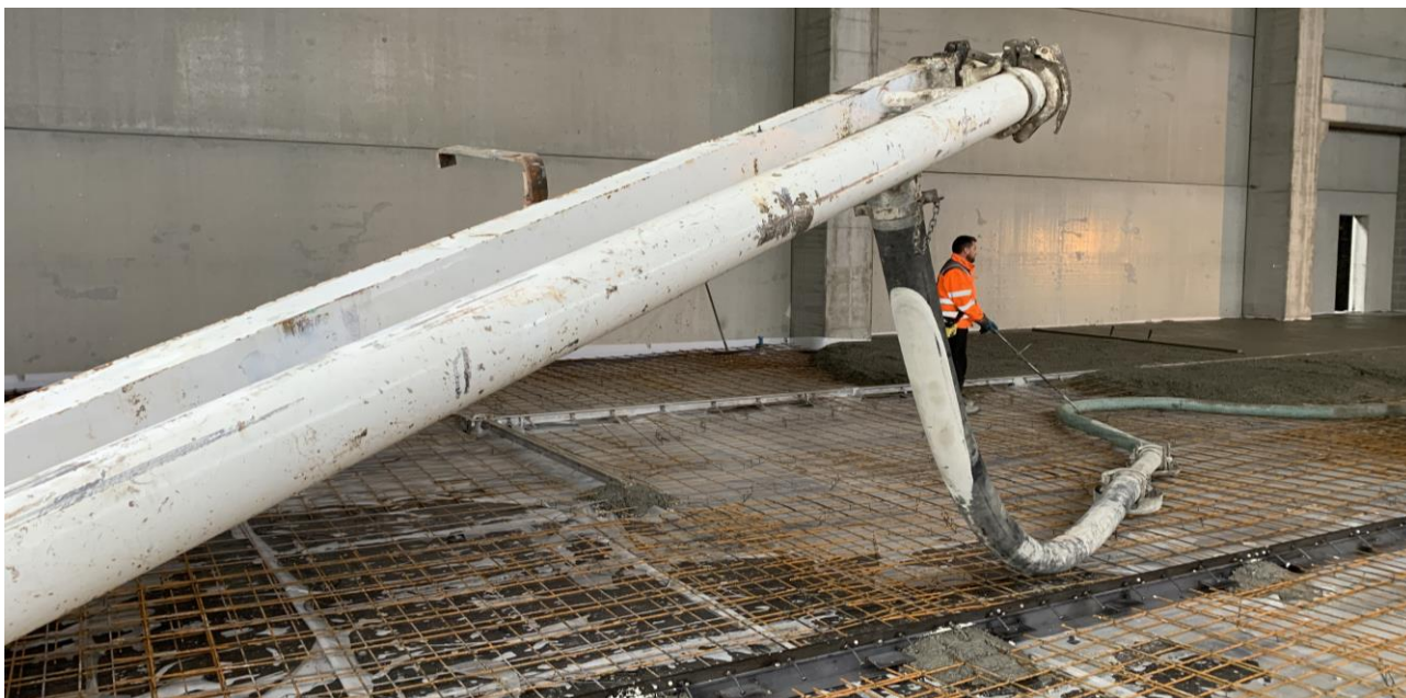
Figura 1. Getto del calcestruzzo fibrorinforzato con ausilio di autopompa
