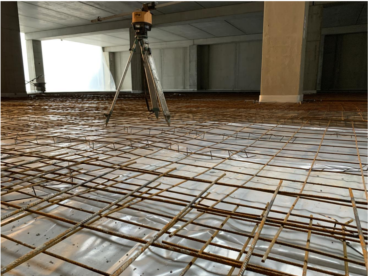
Figura 3. Predisposizione dell'armatura nella sezione di piastra come da prescrizioni progettuali
