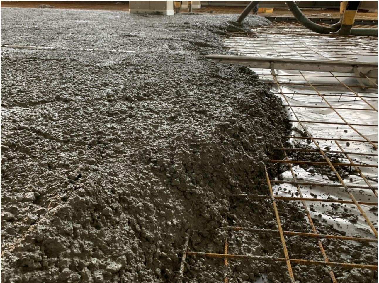
Figura 6. Fasi di getto della pavimentazione fibrorinforzata con FIBRAG® POLY: PSF 55-TP
