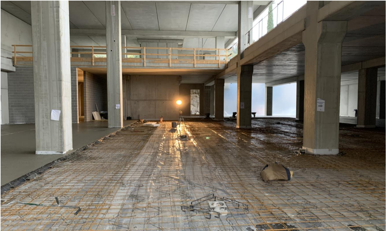
Figura 2. Predisposizione dell'armatura nella sezione di piastra come da prescrizioni progettuali
