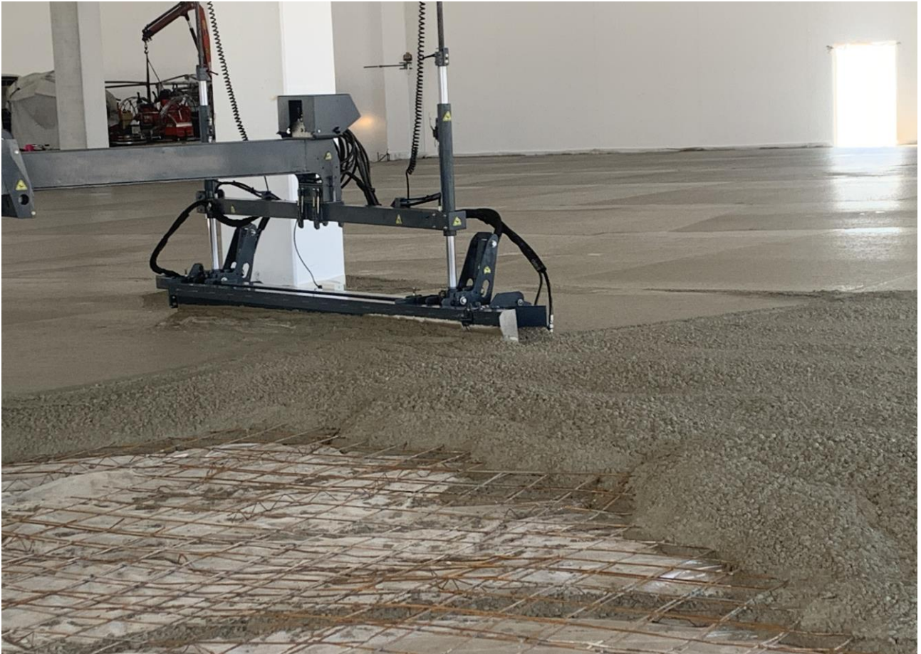
Figura 4. Fasi di getto della pavimentazione con stesura meccanizzata Laser Screed
