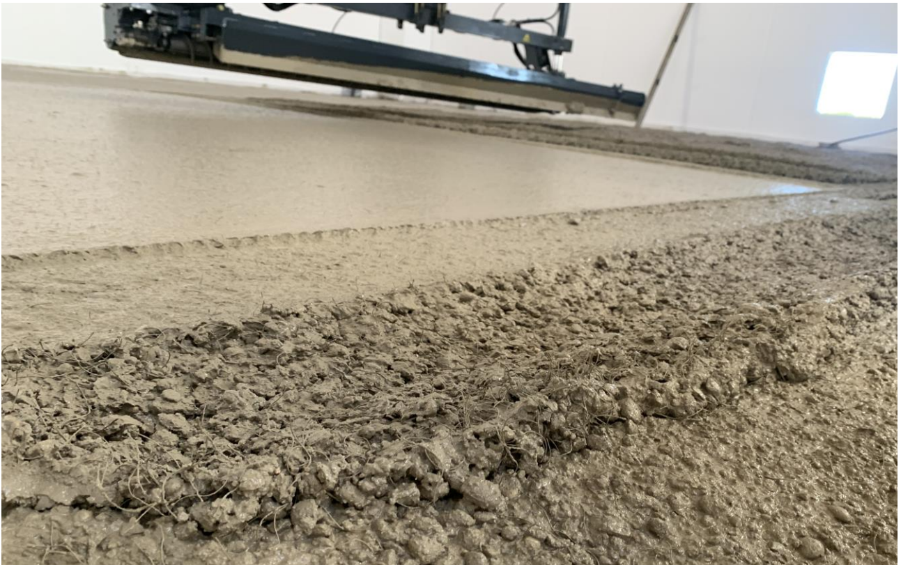
Figura 5. Fasi di getto della pavimentazione fibrinforzata con FIBRAG® POLY: PSF 55-TP
