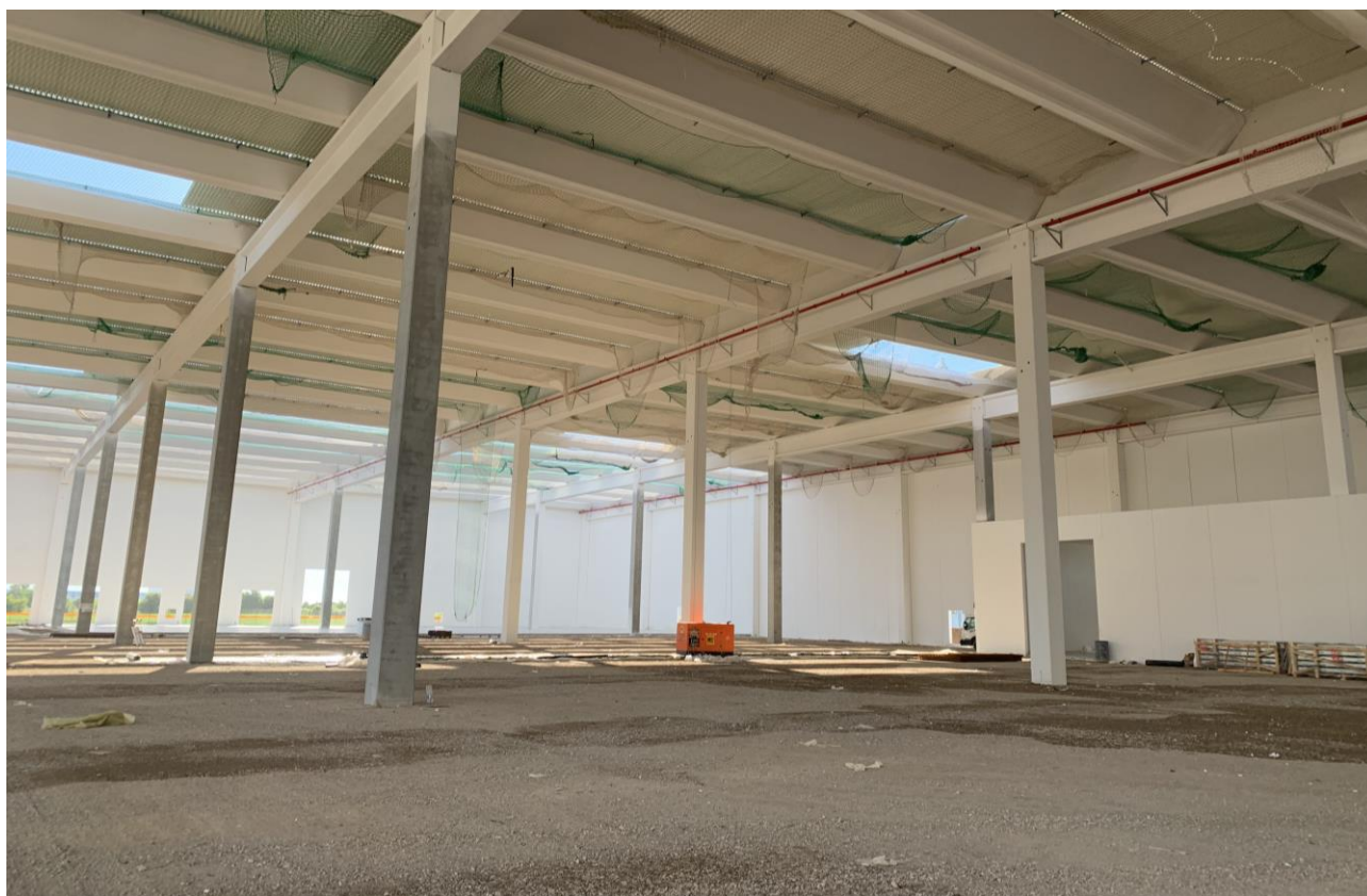
Figura 1. Preparazione del sottofondo della pavimentazione
