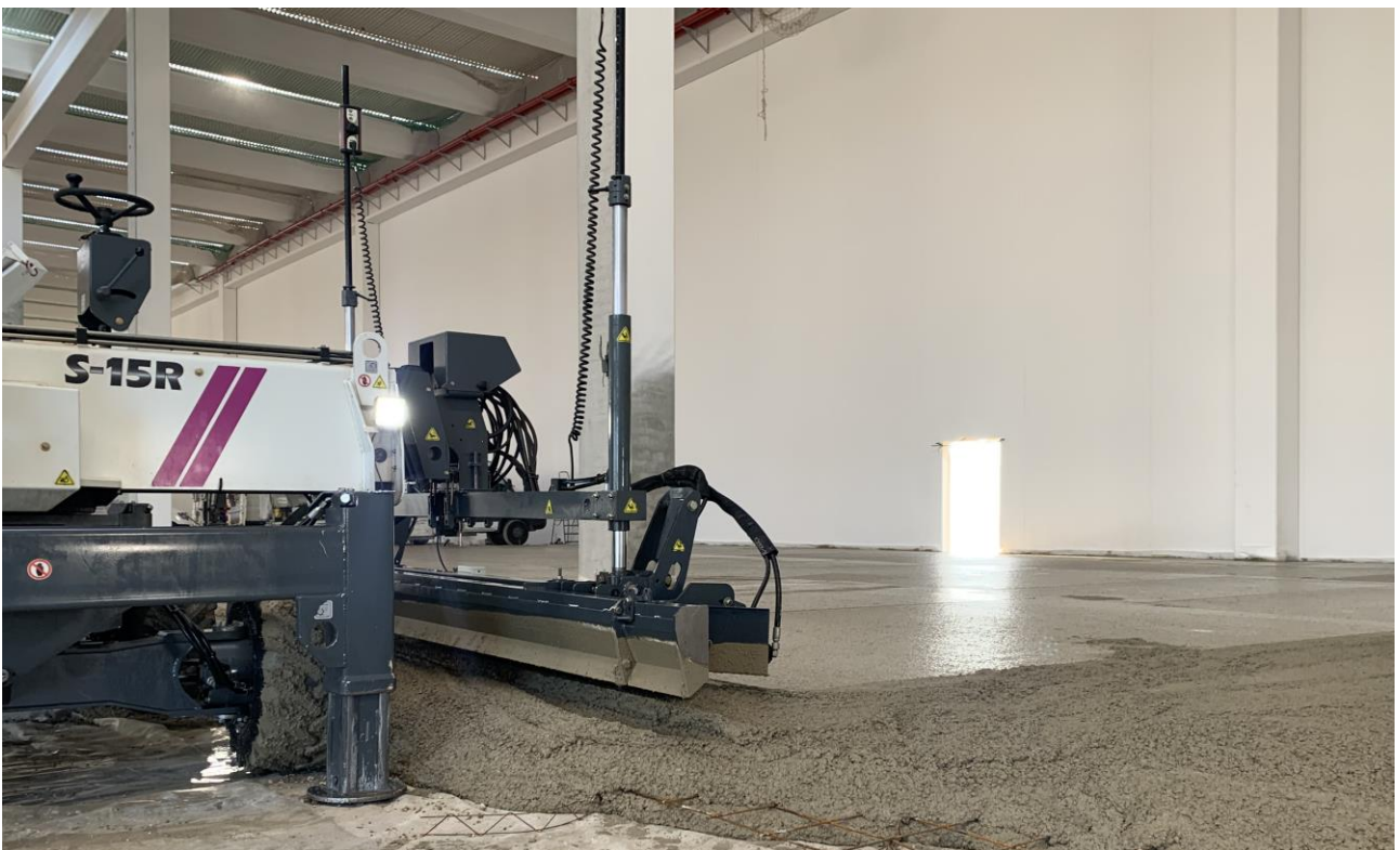
Figura 3. Fasi di getto della pavimentazione con stesura meccanizzata Laser Screed
