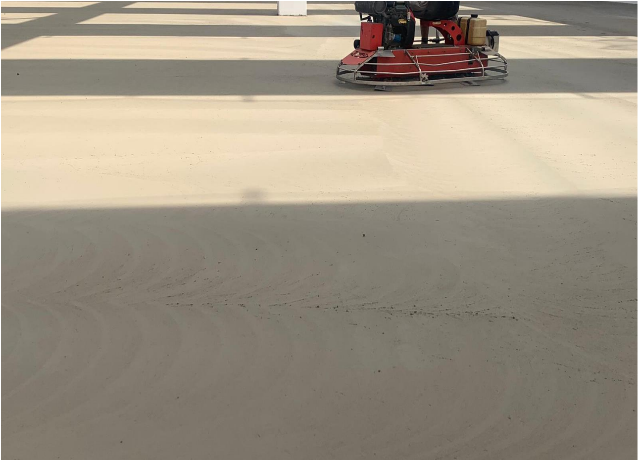
Figura 8. Fase di lisciatura della pavimentazione industriale
