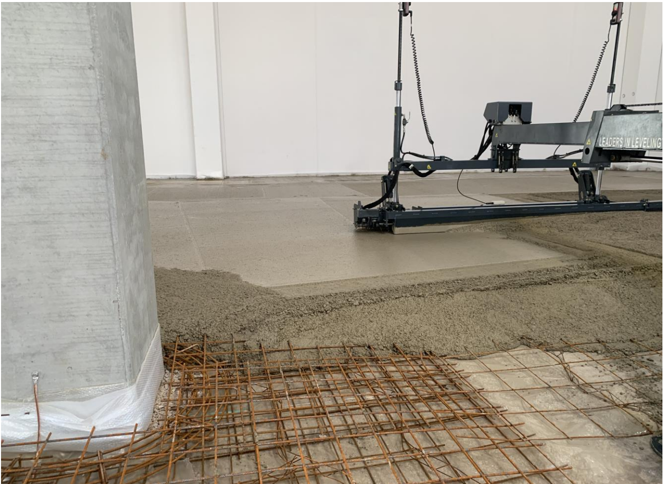
Figura 6. Particolare del rinforzo aggiuntivo di armatura superiore in corrispondenza di pilastri (angoli liberi) come da prescrizioni progettuali
