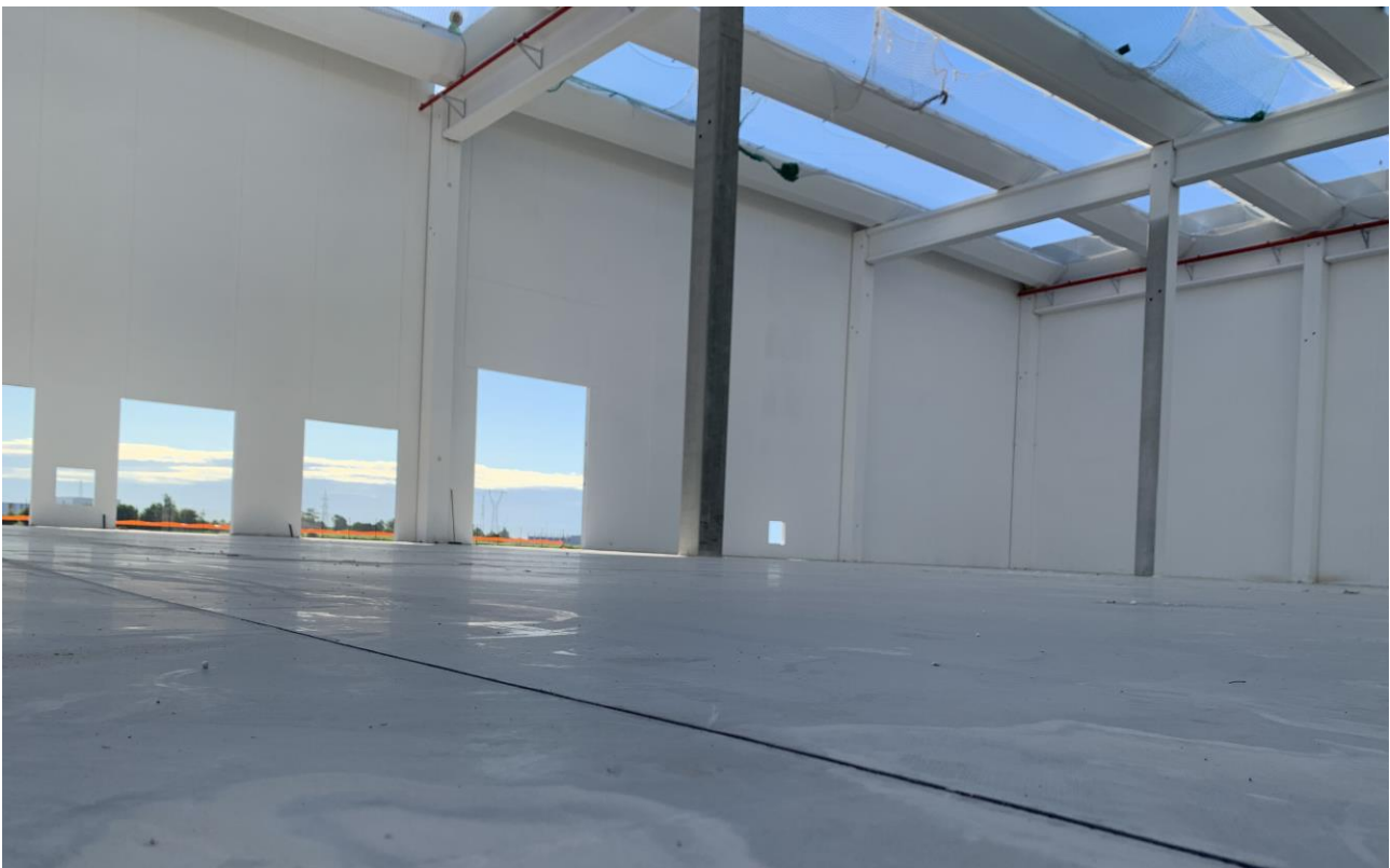
Figura 9. Vista della pavimentazione ultimata
