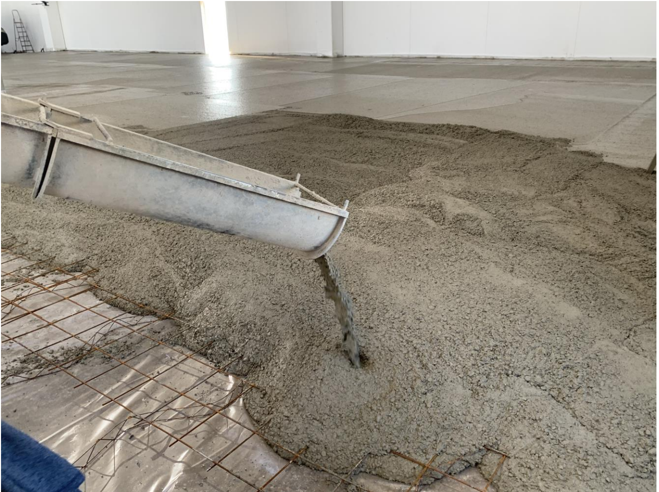
Figura 2. Fasi di getto della pavimentazione fibrinforzata con FIBRAG® POLY: PSF 55-TP
