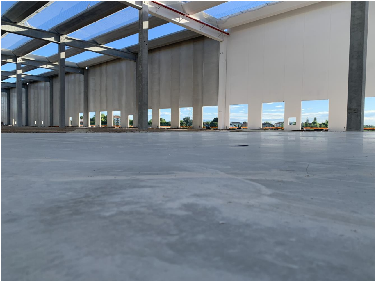
Figura 10. Vista della pavimentazione ultimata
