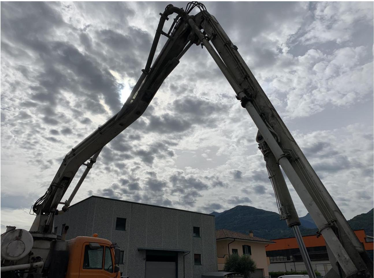
**Figura 4.** Getto del calcestruzzo con ausilio di autopompa
