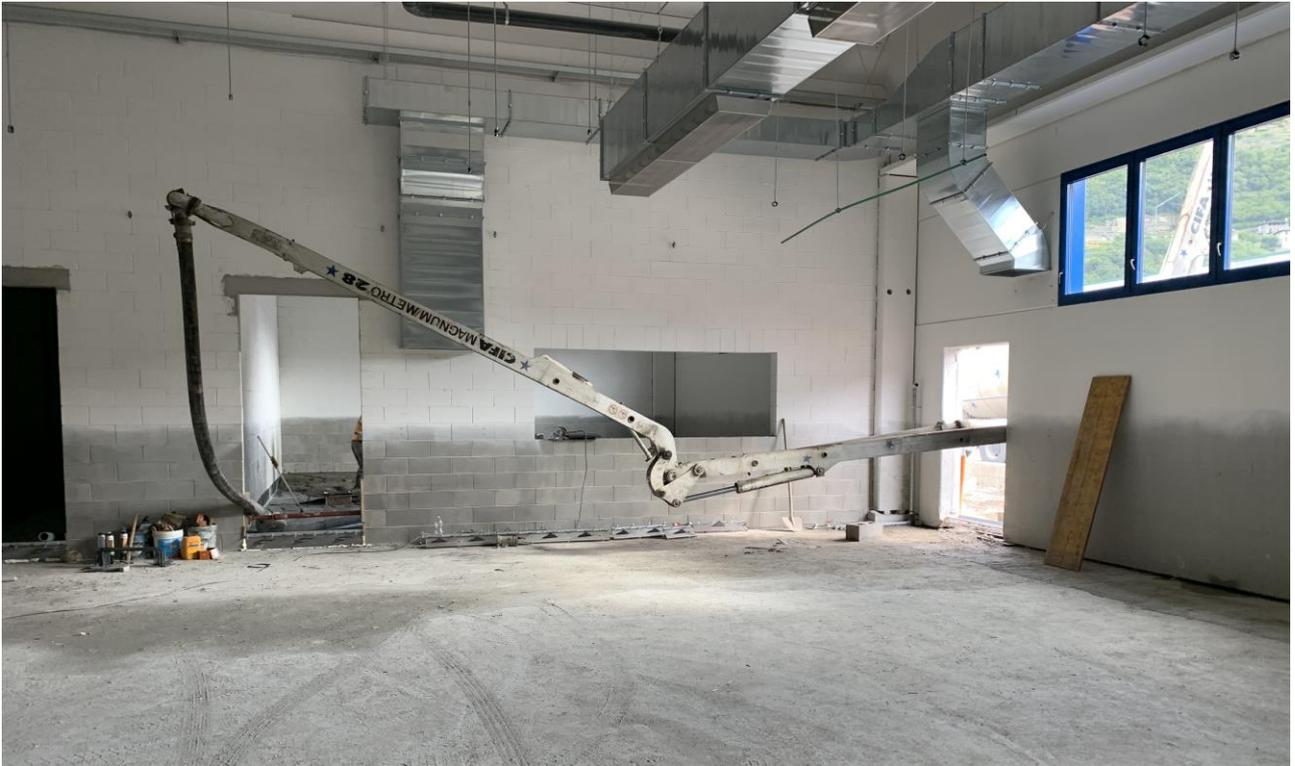
**Figura 3.** Getto del calcestruzzo con ausilio di autopompa
