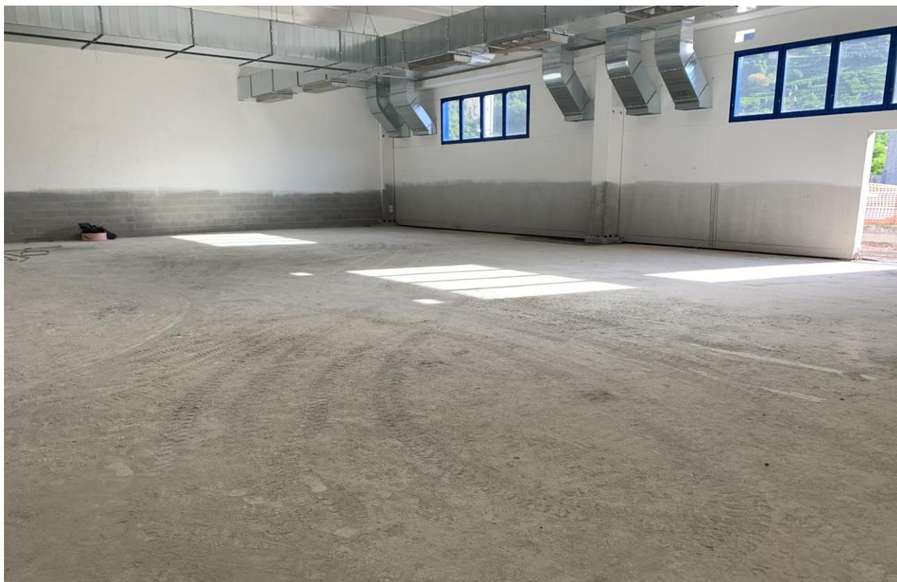
**Figura 2.** Preparazione del sottofondo della pavimentazione
